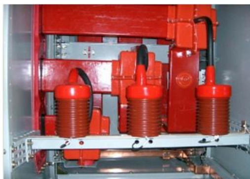
Rys. 4.2.6. Sposób zamontowania kondensatorów na końcu głównej magistrali (z lewej) i na części przejściowej magistrali głównej [123,125,127]
