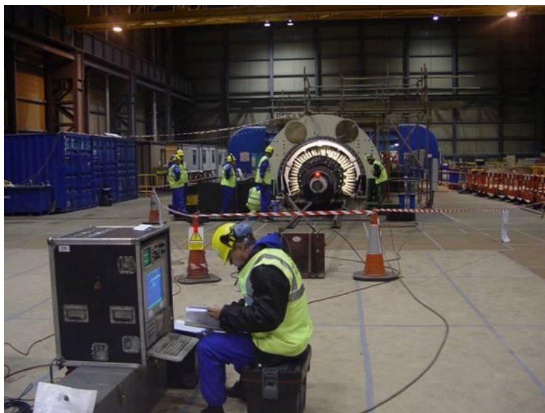
Rys. 9.1. Badania wyładowań niezupełnych izolacji uzwojeń stojana turbogeneratora o mocy 300 MW, TEAS 570 firmy Haefely, w elektrowni Moneypoint w Irlandii [157]
