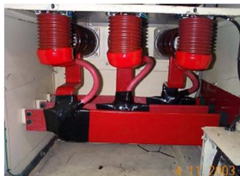
Rys. 4.2.6. Sposób zamontowania kondensatorów na końcu głównej magistrali (z lewej) i na części przejściowej magistrali głównej [123,125,127]
