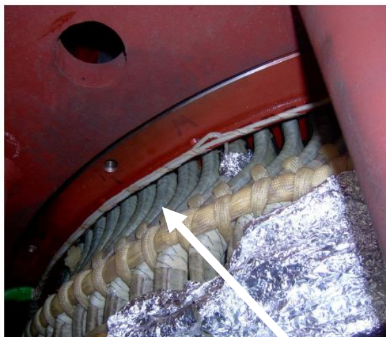
Rys. 4.2.21. Wnętrze stojana z fragmentem anteny pętlowej [127,129]
