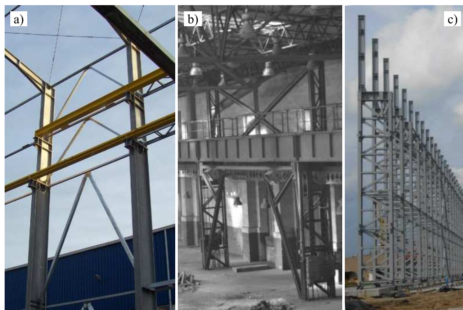
Rys. 1.4. Skrajne słupy hal przemysłowych: a) pełnościennie, b) kratowe, c) mieszane
