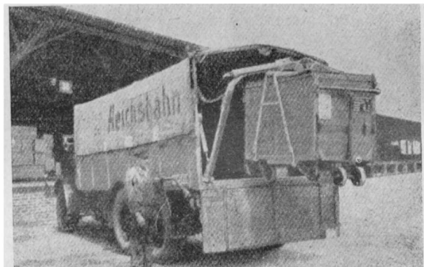
Rys. 5. Samochód ciężarowy kolei niemieckich (Reichsbahn) z urządzeniem do ładowania skrzyń przewozowych.
