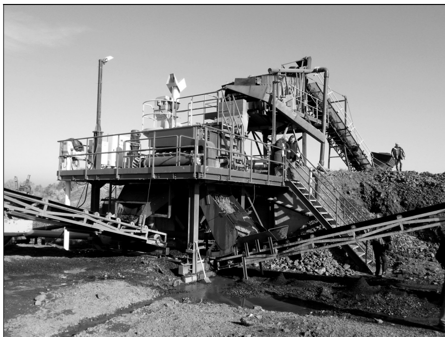
Rys. 4. Klasyfikator pulsacyjny K-102 zabudowany w instalacji do rekultywacji składowiska pokopalnianego
