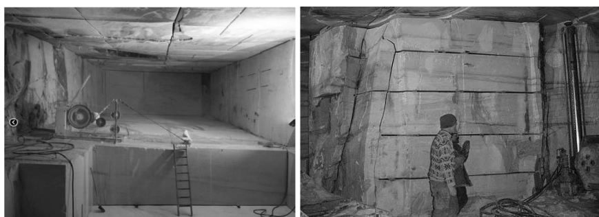
Rys. 4. Cięcie marmurów za pomocą wrębiarki łańcuchowej i diamentowej piły linowej w kopalni Acqua Bianca ( www.angusboulton.net , www.sagen.at )
