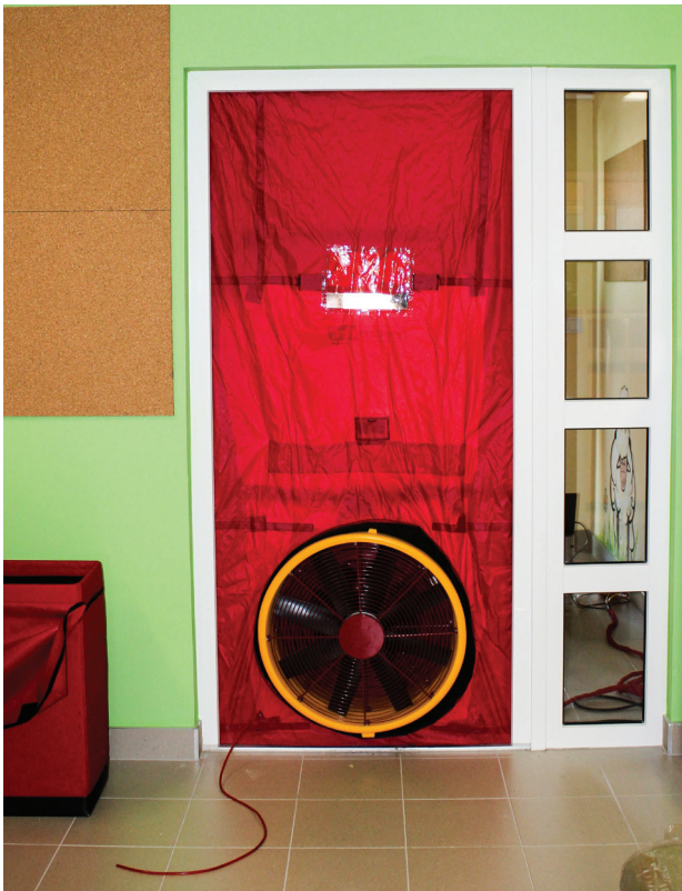
Il. 4. Drzwi nawiewne blower door zamocowane w drzwiach wejściowych do lokalu mieszkalnego Fig. 4. Blower door sealed into the front door of a residential unit
