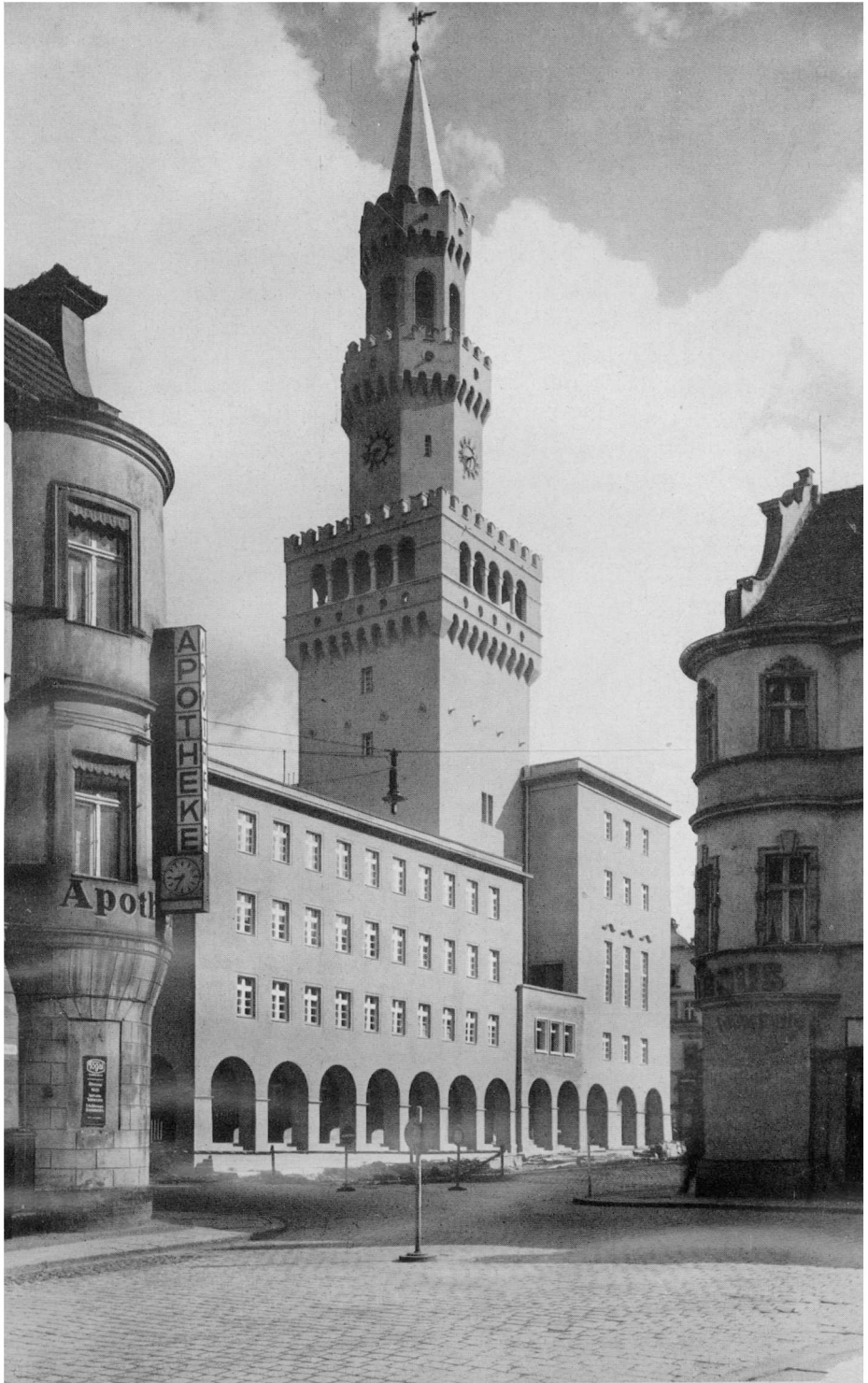
Der Neubau von Südwest
