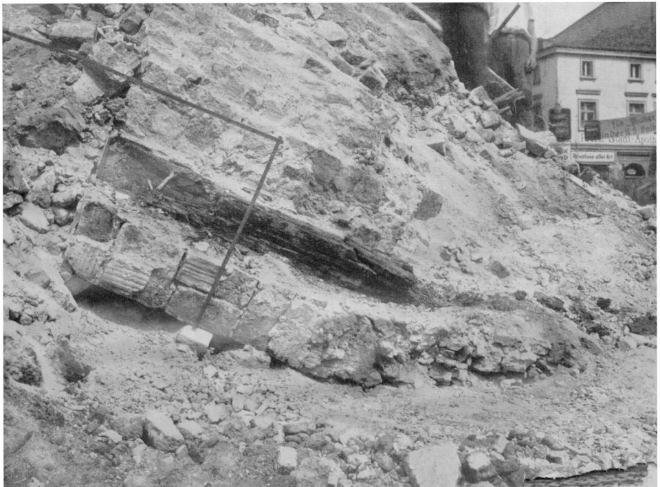
12 Reste der mittelalterl. Holz= verankerung im Turm
