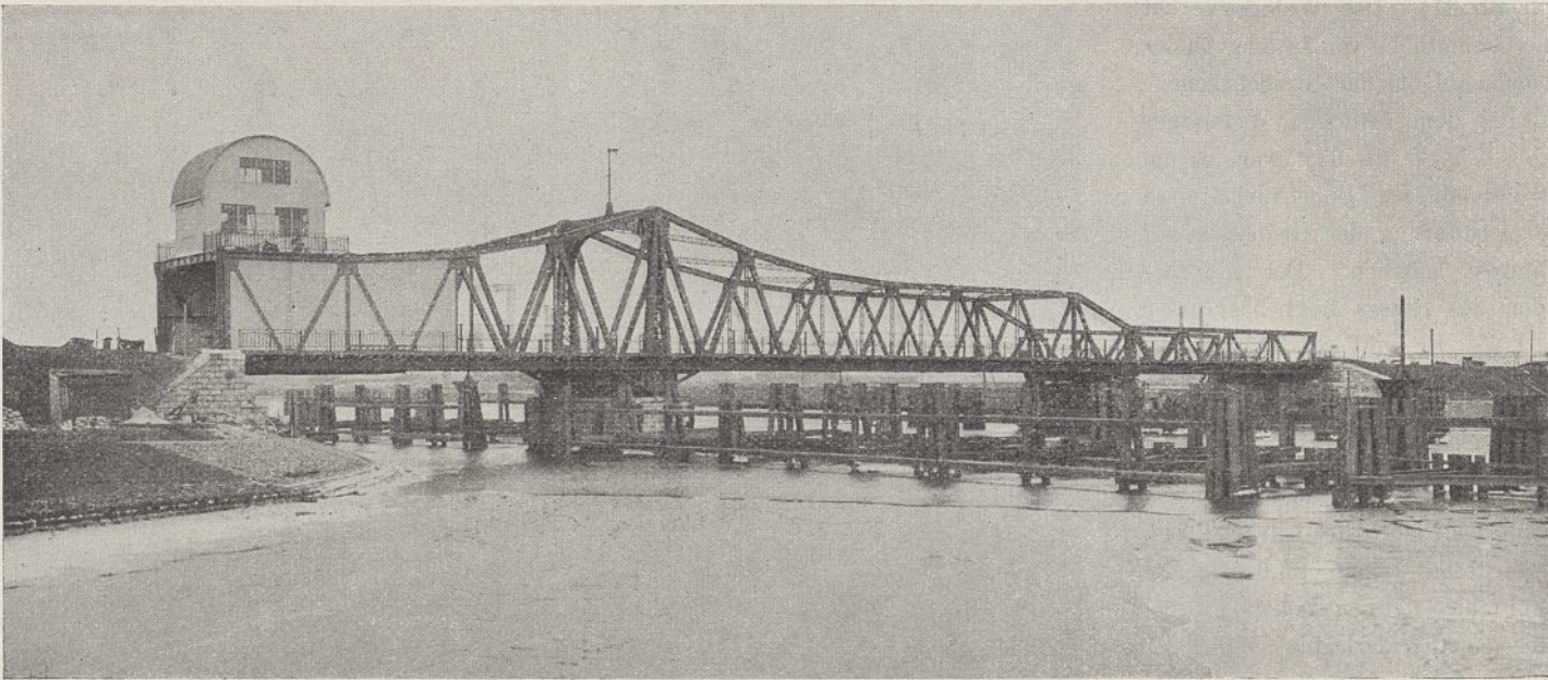
Abb. 30. Drehbrücke. Ansicht vom Hafenbecken.
