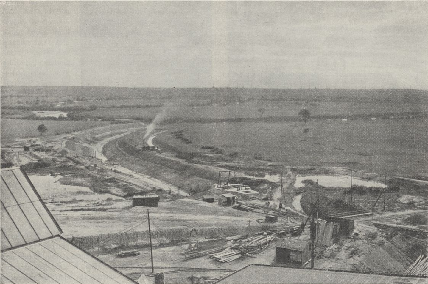
Abb. 22. Bau der offenen Kanäle der Wasserversorgungsanlage für den Kondensationsbetrieb.
