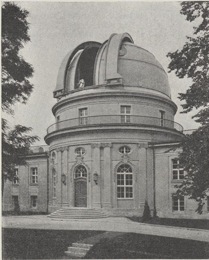
Abb. 11. Hauptgebäude, Mittelbau von Süden.
