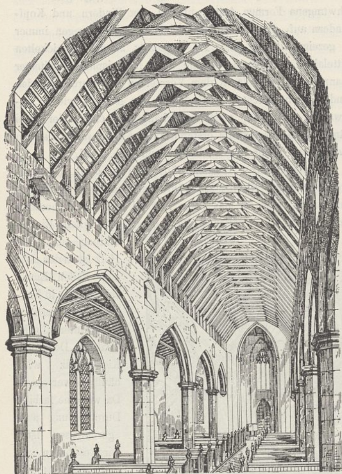
Abb. 44. Freitragendes Sparrengebände-Dach aus der Kirche in Filby.
