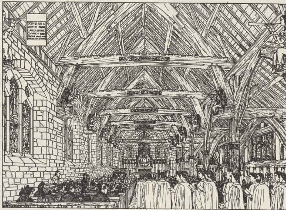
Abb. 47. Offener Dachstuhl einer Dorfkirche.
