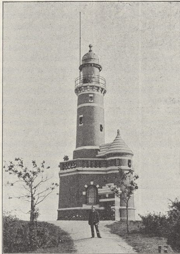
Abb. 327. Leuchthurm zu Holtenau.
