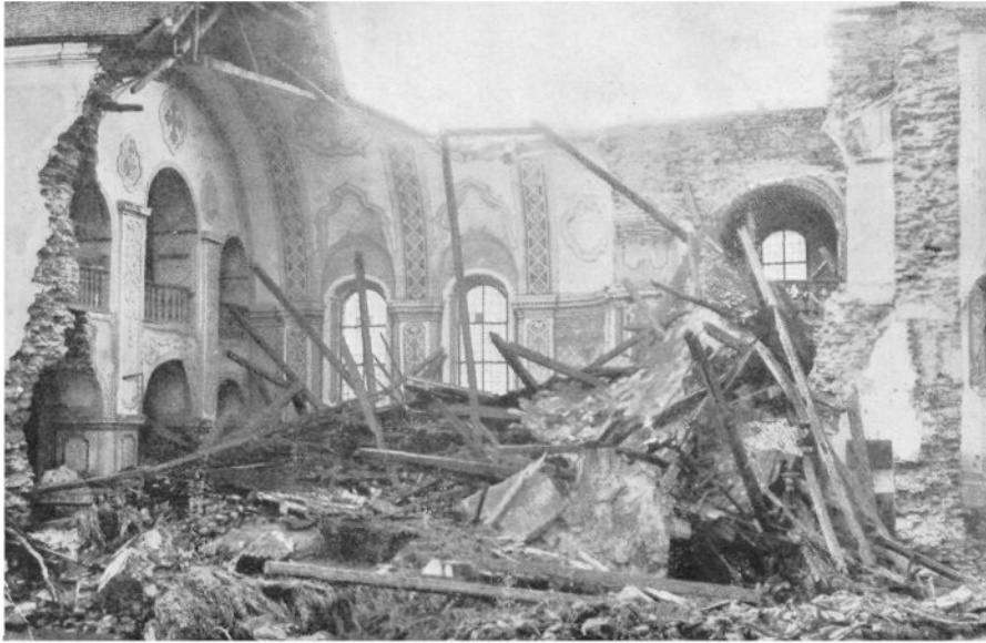
Die durch Hochwasser zerstörte Kirche in Arnoldsdorf
