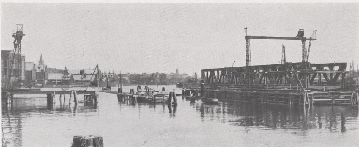
Abb. 65. Montage der Drehbrücke.
