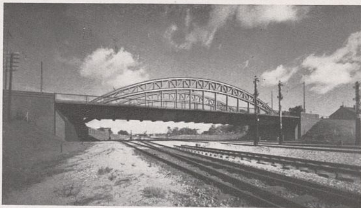
Abb. 21. Das fertige Bauwerk.
