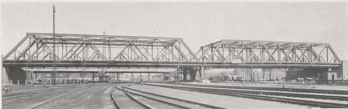
Abb. 45. Ansicht des fertigen Bauwerks.
