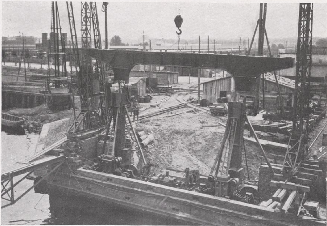
Abb. 67. Aufstellen des Pendelrahmens am Pfeiler E.
