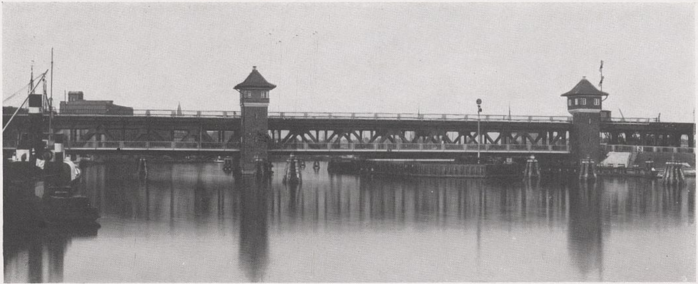
Abb. 71. Strombrücke von Westen aus, geschlossen.
