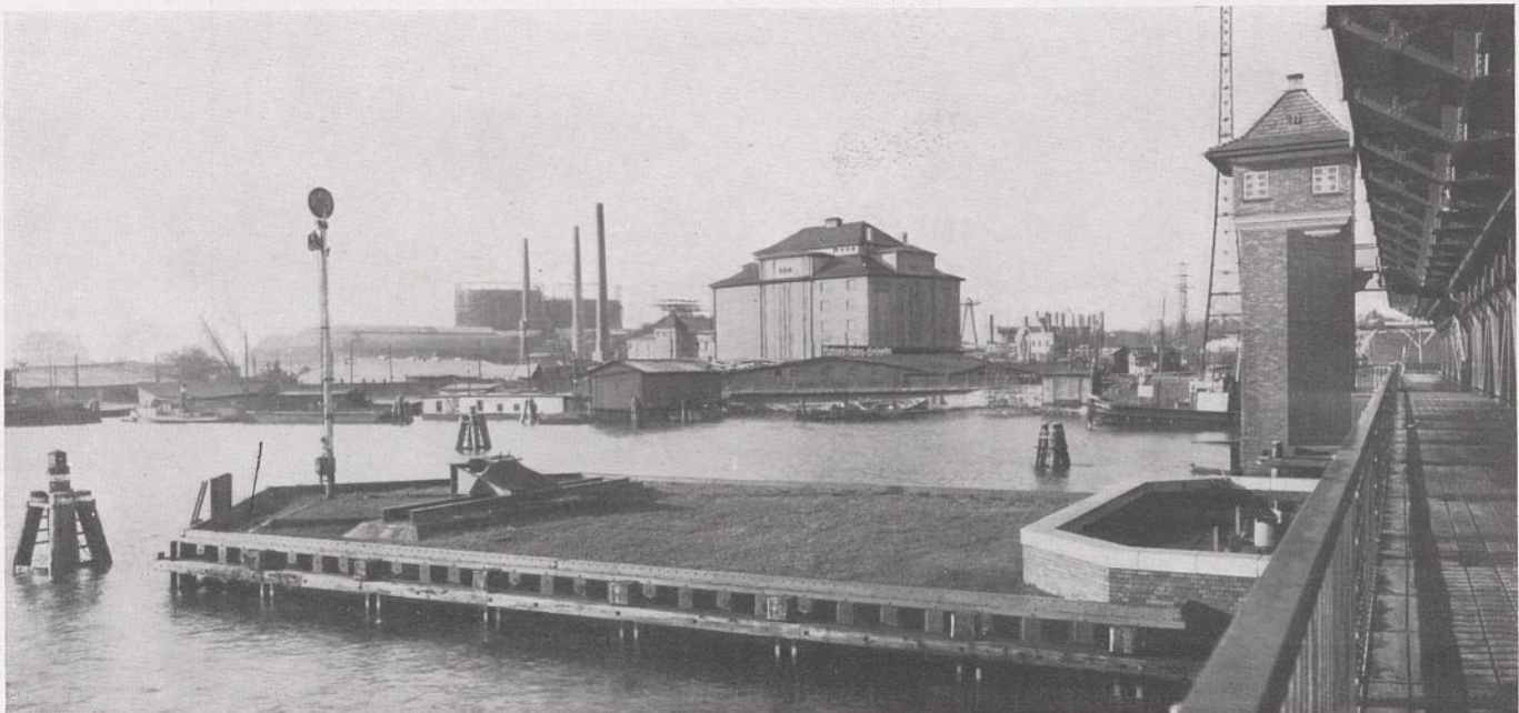
Abb. 70. Schutzwerk für die Drehbrücke in geöffneter Stellung.
