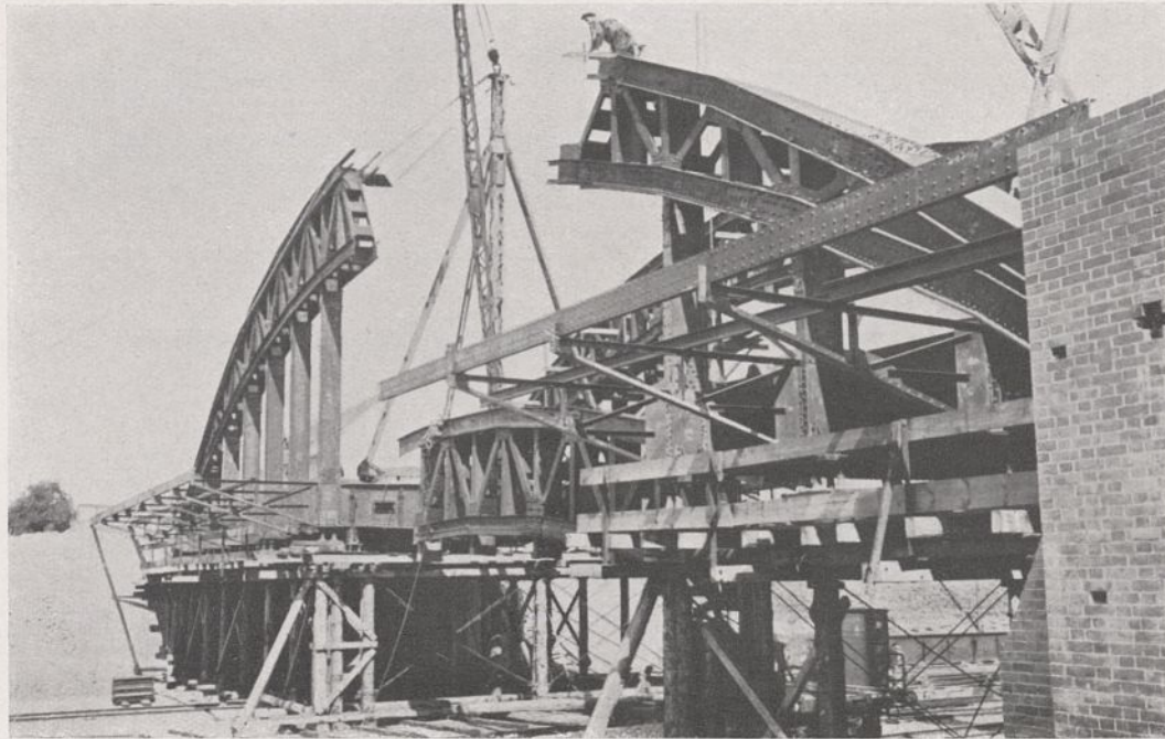
Abb. 19. Einbringen des Bogenschlußstückes.
