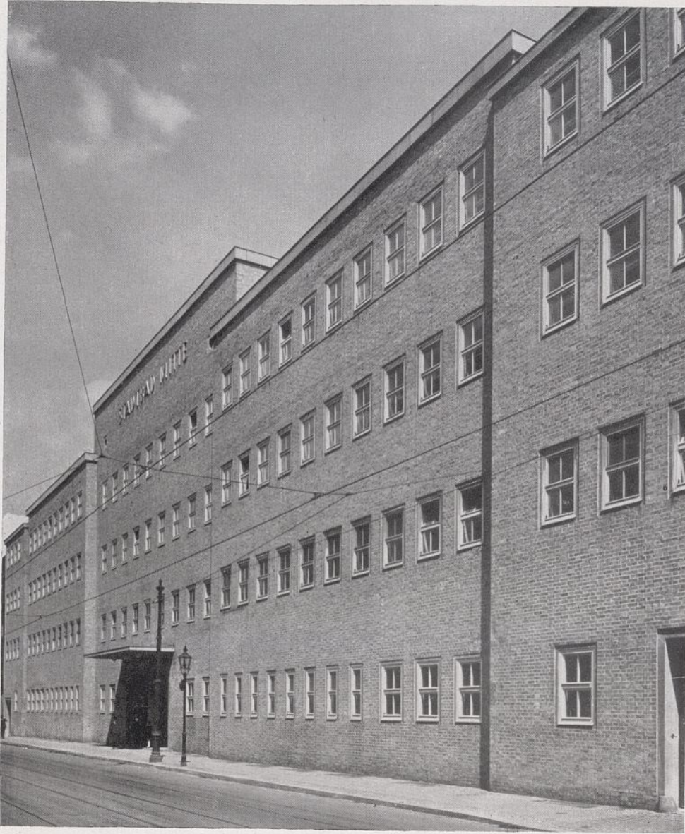
Ansicht von der Gartenstraße. Hegermühler Klinker.
