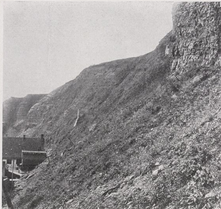
Abb. 13. Bewachsene Absturzhalde an der Ostseite.
