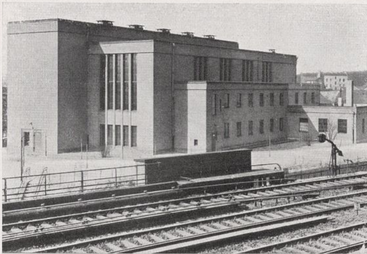
Abb. 25. Umformerwerk Pankow, am Schnittpunkt der drei Nordstrecken.
