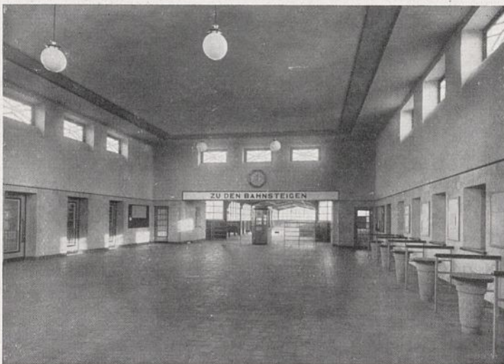
Abb. 4. Halle mit Zugangsbrücke.
