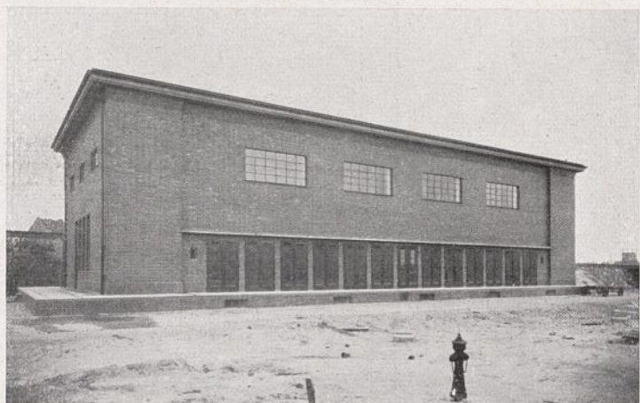
Abb. 28. Gleichrichterwerk Niederschöne weide.
