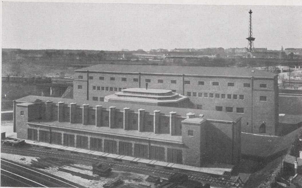
Abb. 41. Hauptschaltwerk Markgrafendamm. Links Hochspannhaus, rechts Schalthaus.
