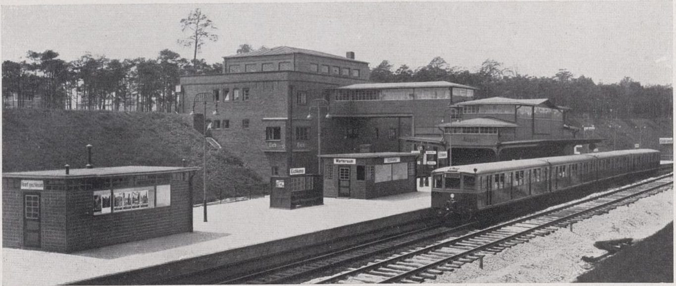
Abb. 6. Bahnsteigseite. Die Bahnsteigüberdachung ist noch nicht ausgeführt. Beabsichtigt ist eine spätere Überbrückung zum jenseitigen Gelände.
