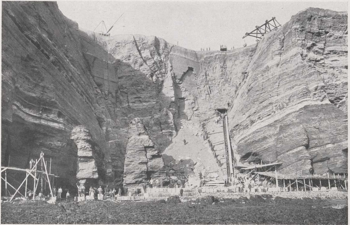
Abb. 26. Probestrecke von 1905, Ansicht der Baustelle.
