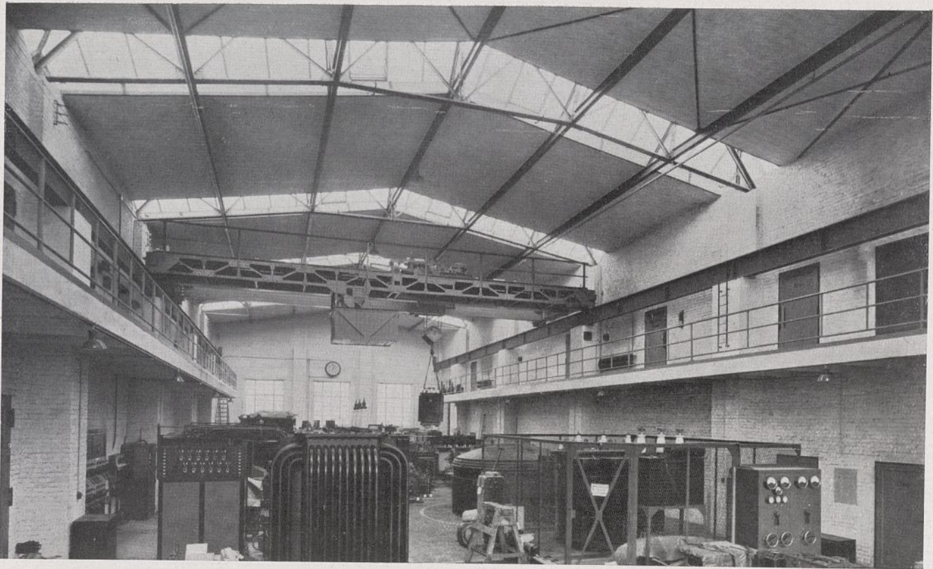
Abb. 52. Ueberwachungswerk Markgrafendamm, Werkstatthalle.
