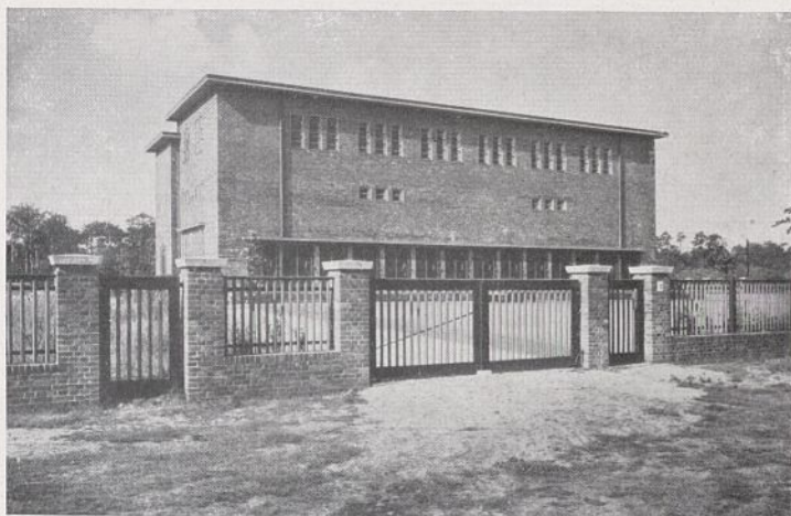
Abb. 53. Gleichrichterwerk Cöpenick, Straßenseite. Besonderes Kabelgeschoß.
