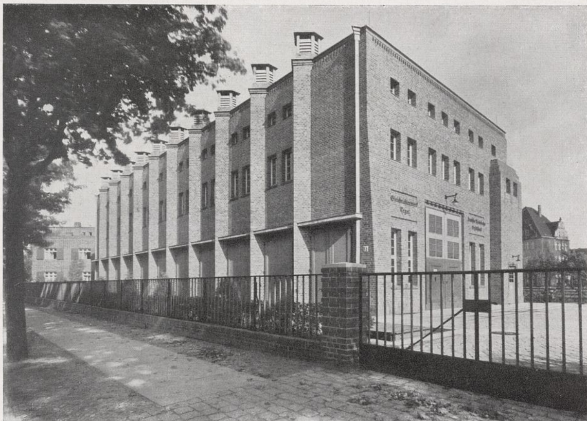
Abb. 27. Gleichrichterwerk Tegel, Straßenansicht. Im Hintergrund das zugehörige Beamtenwohnhaus.
