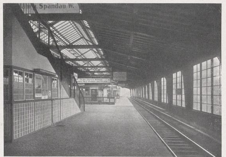
Abb. 5. Ringbahnhalle mit Aufgang zum Empfangsgebäude.
