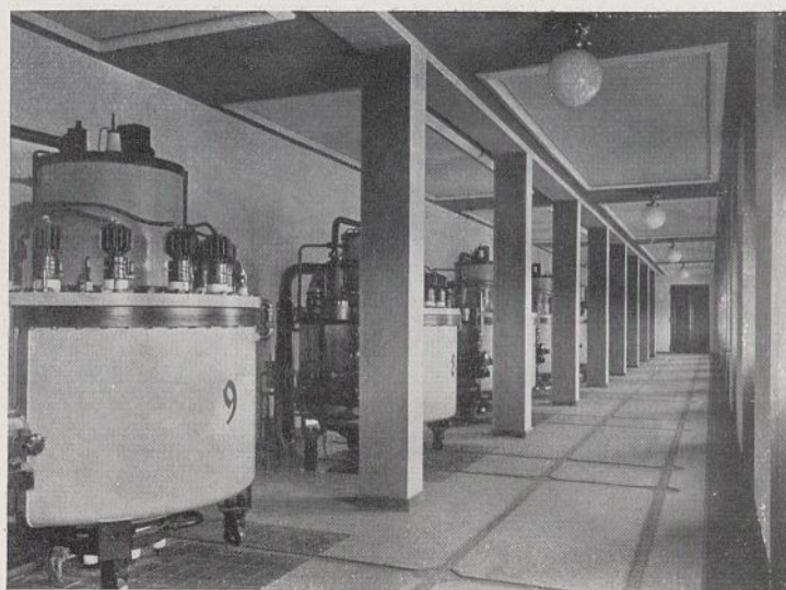
Abb. 48. Gleichrichterraum. Im Gange Schienen zur Beförderung der Gleichrichter zum Aufzug.
