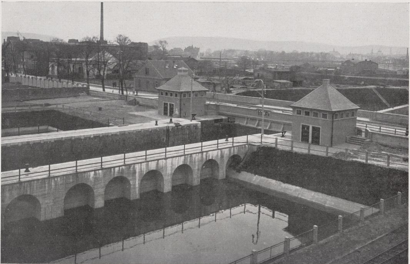
Abb. 25. Ansicht des Unterhauptes mit den beiden Steuerhäusern für die Motoren des Sieltores und Zylinderschützes.
