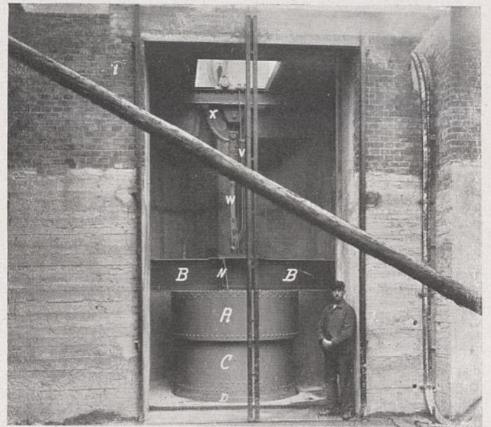
Abb. 20. Ein niedriges Zylinderschütz in eingebautem Zustande.
