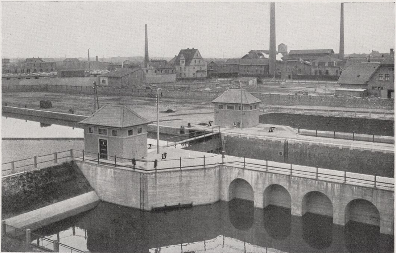
Abb. 22. Ansicht des Oberhauptes mit den beiden Steuerhäusern für die Motoren des Klapptores und der Zylinderschütze.
