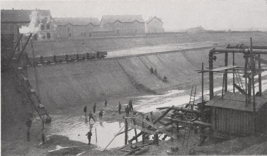
Abb. 5. Gewinnung des Kieses im zweiten-Baggerschnitt und erste Wasserhaltungsanlage.
