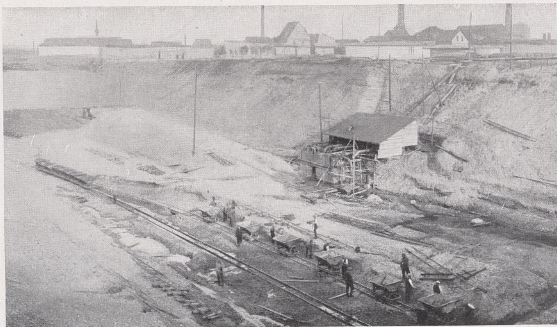
Abb. 6. Zweite Wasserhaltungsanlage.
