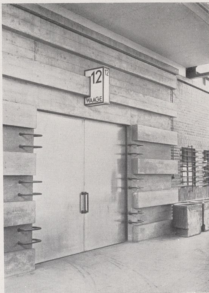
Einfahrt zur Waage.
