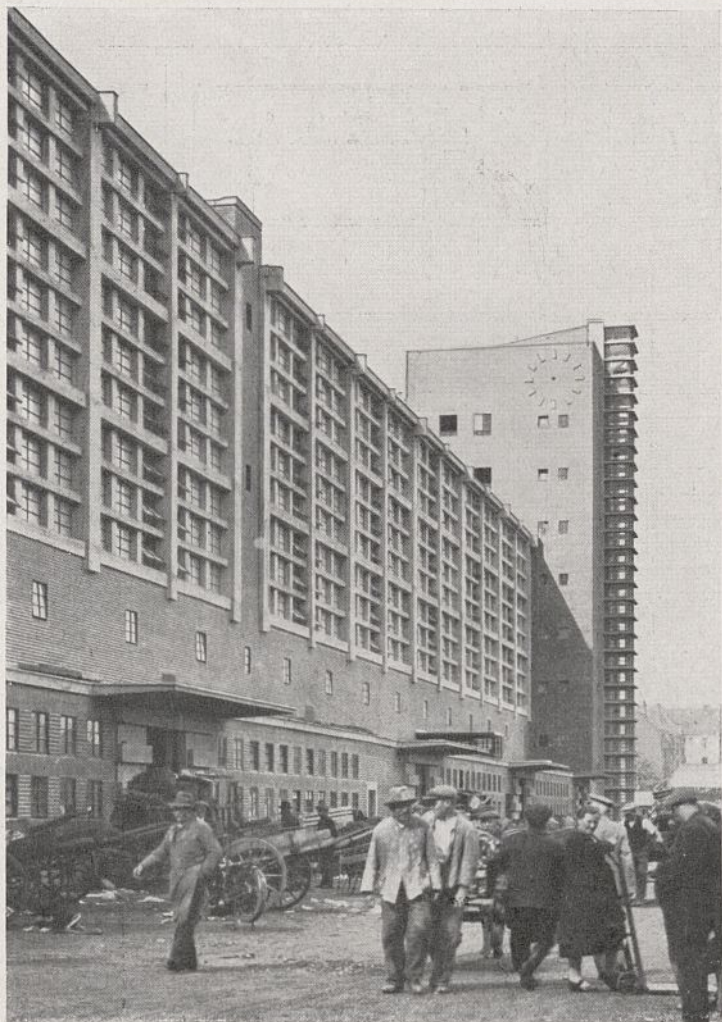
Hofseite der Großmarkthalle.
