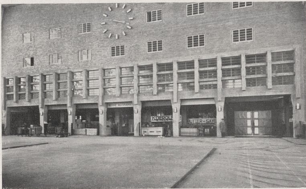
INNERES DER GROSSMARKTHALLE. BLICK AUF DIE HALLENSTIRNWAND.
