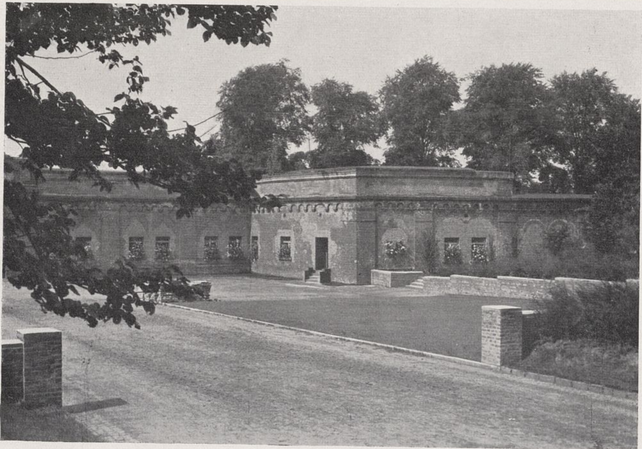
Ehemaliges Fort Deckstein. Mittelplatz des Kernwerks.
