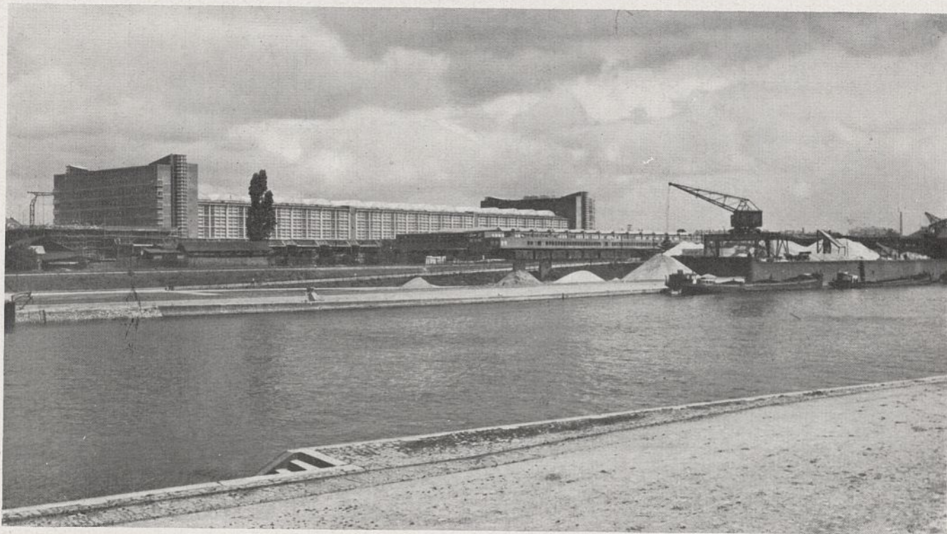
Gesamtansicht von der Mainseite aus.
