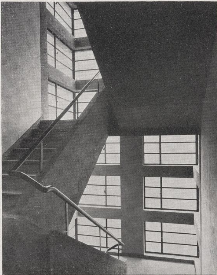
Treppe im Kühlhaus.
