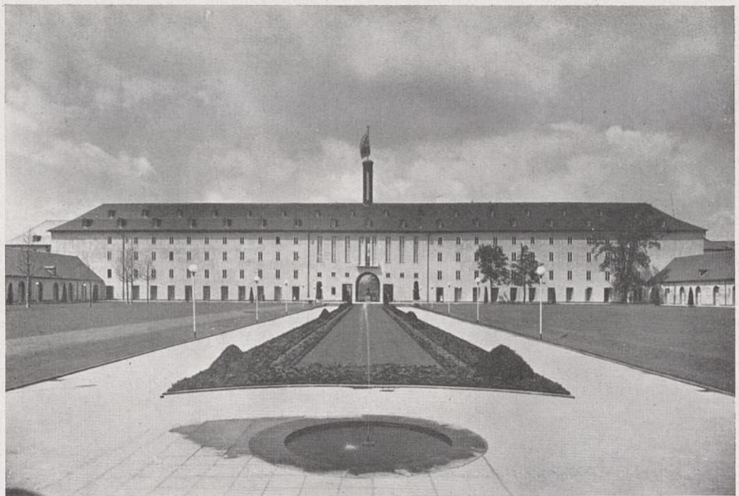
Abb. 6. UMBAU DER KÜRASSIER- KASERNE. HOFSEITE DES HAUPTBAUES.
