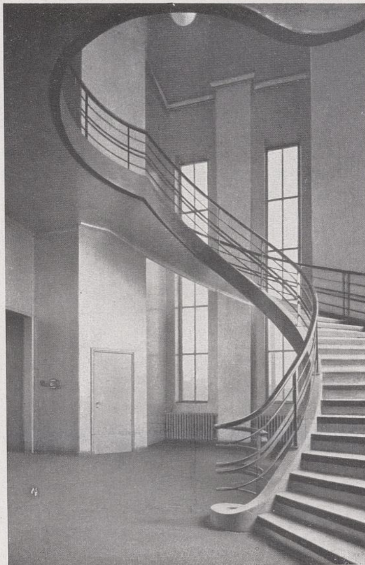
Abb. 19. Eingangshalle im Turm.
