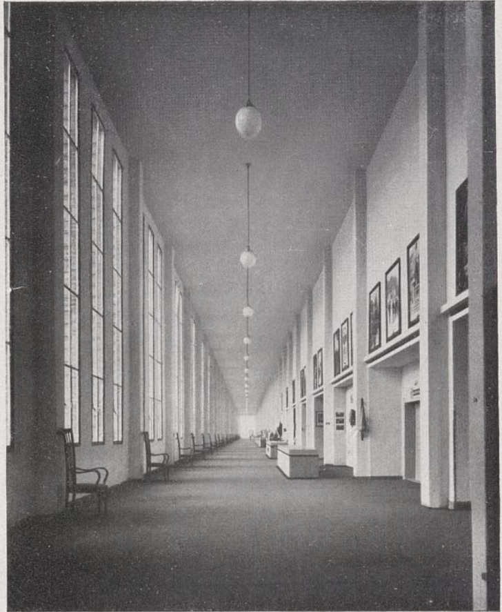
Abb. 15. AUSSTELLUNGSHALLEN, OBERGESCHOSS AN DER LANGSWAND DER NEUEN UMMANTELUNGSBAUTEN.
