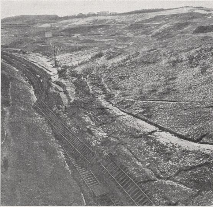
Abb. 2. Rutschung bei Rosengarten am 27. Dezember 1925. Ansicht von Westen von der großen Betonbrücke aus.
