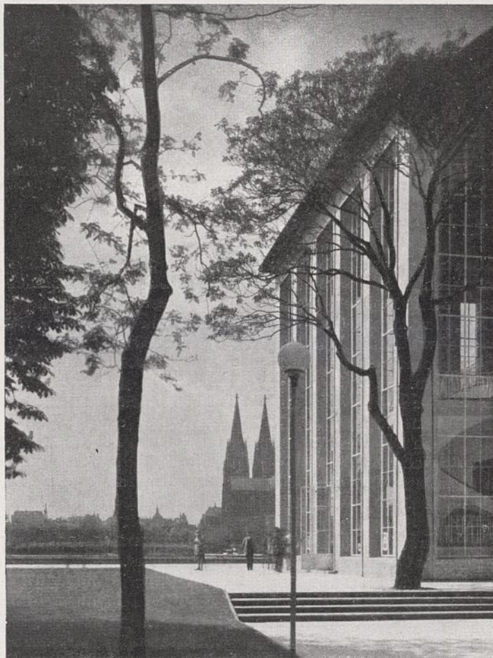
Abb. 1. Nördliches Treppenhaus der Museumsbauten.
