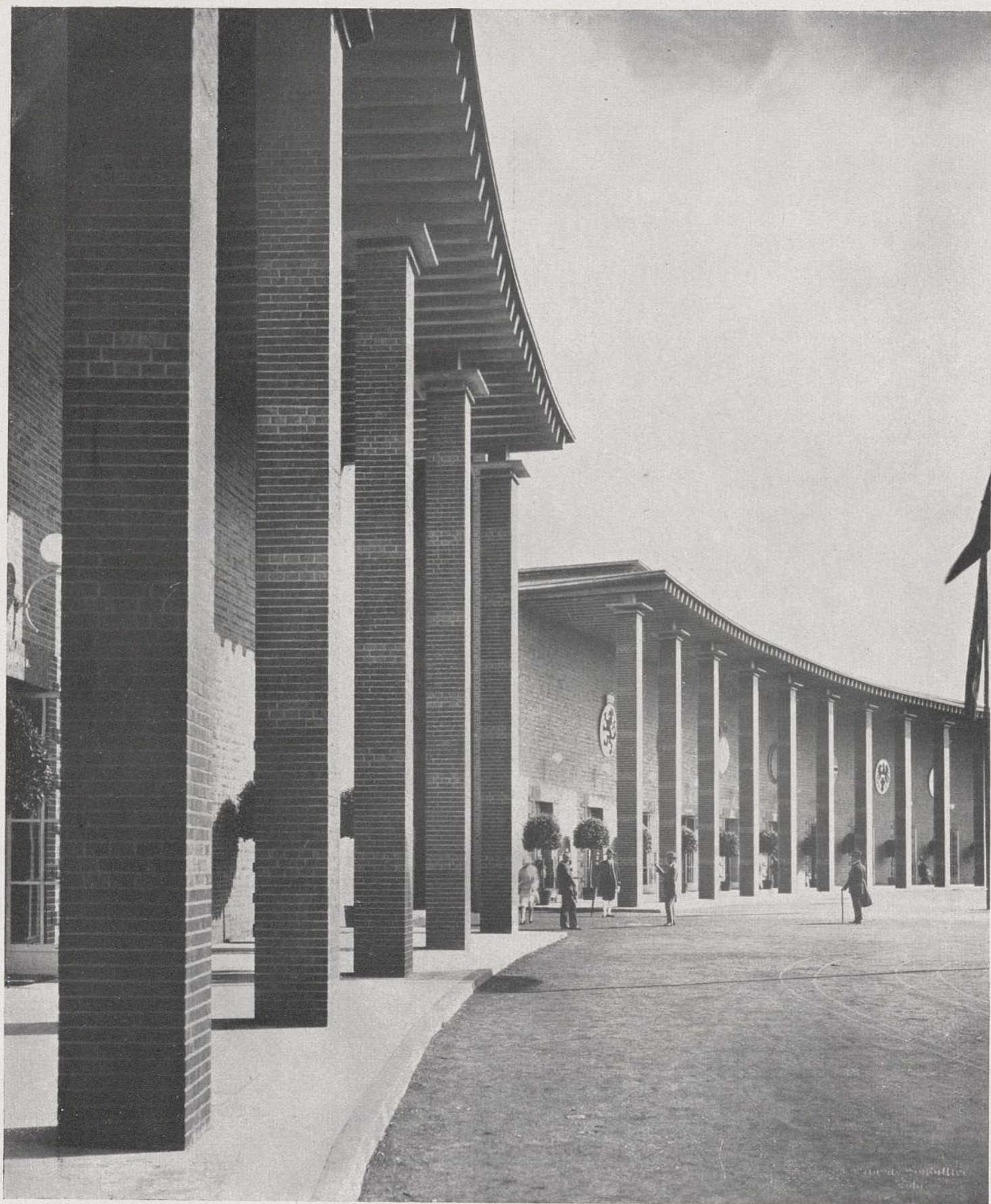
Pfeilerhalle am Gartenrund (Staatenhaus).
