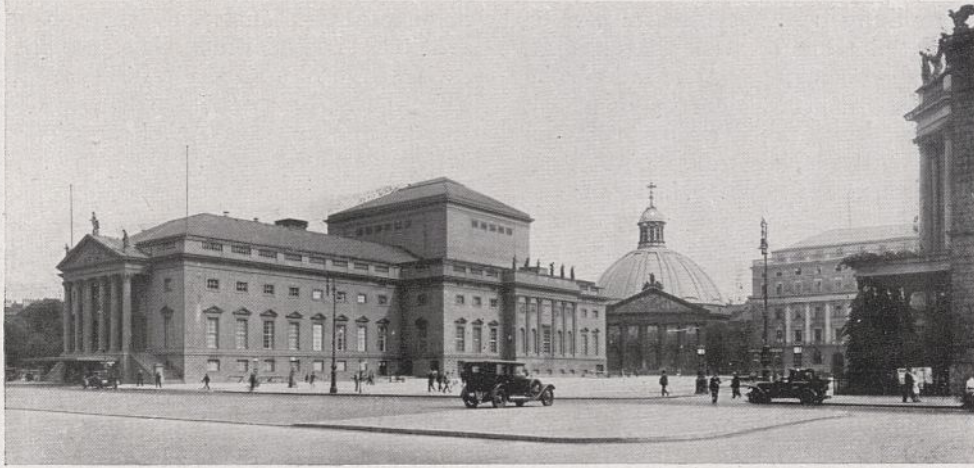
Abb. 51. Außenansicht nach dem Umbau von der Straße Unter den Linden her gesehen.
