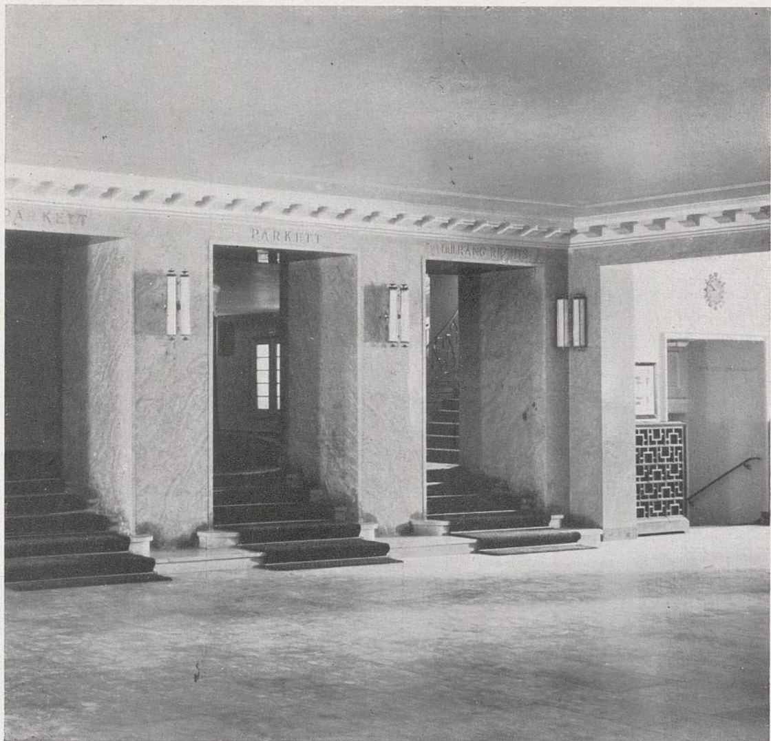
Abb. 27. Vestibül, neuer Zustand.
