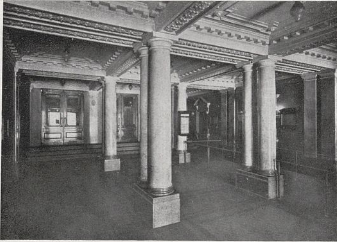
Abb. 25. Vestibül, alter Zustand.
