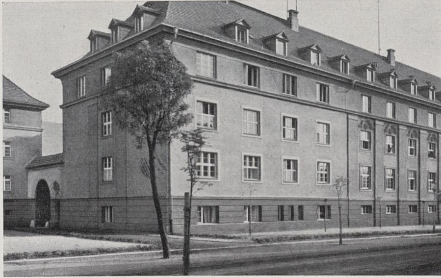
Abb. 96. Hindenburg O.-S. Hauptgebäude.
