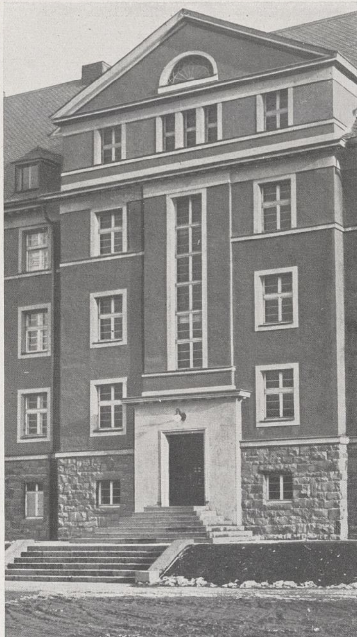
Abb. 69. Barmen. Bereitschaftsgebäude, Hofansicht.
