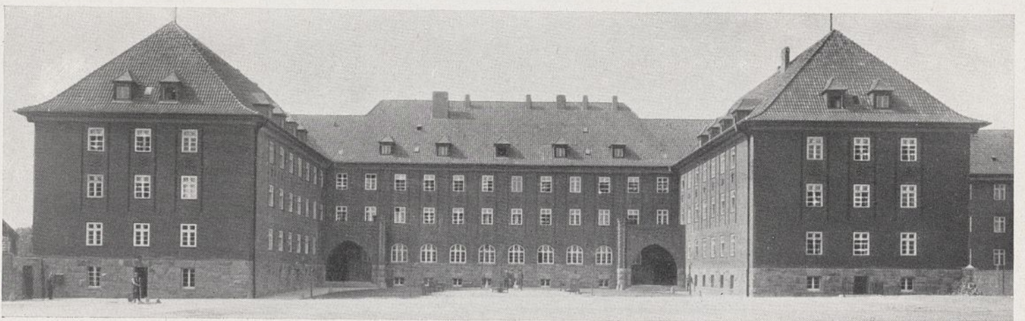
Abb. 58. Bochum. Bereitschaftsgebäude, Hofansicht.
