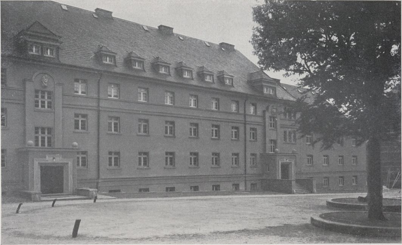
Abb. 65. Remscheid. Bereitschaftsgebäude, Hofansicht.
