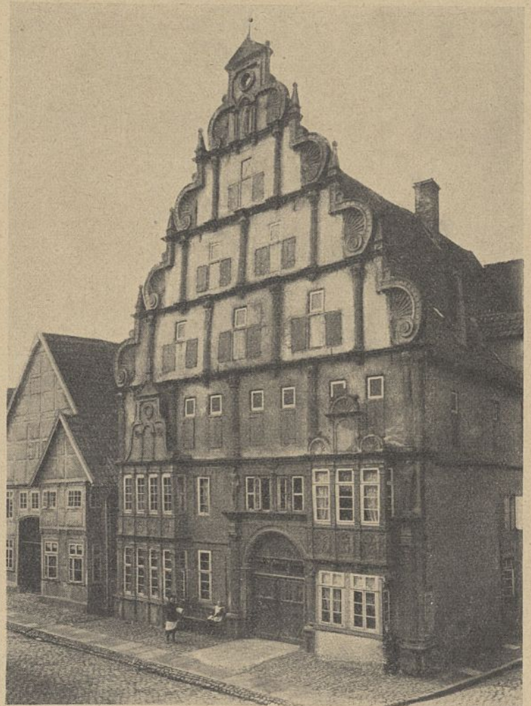
Abb. 29. Hexenbürgermeisterhaus in Lemgo i. L.
