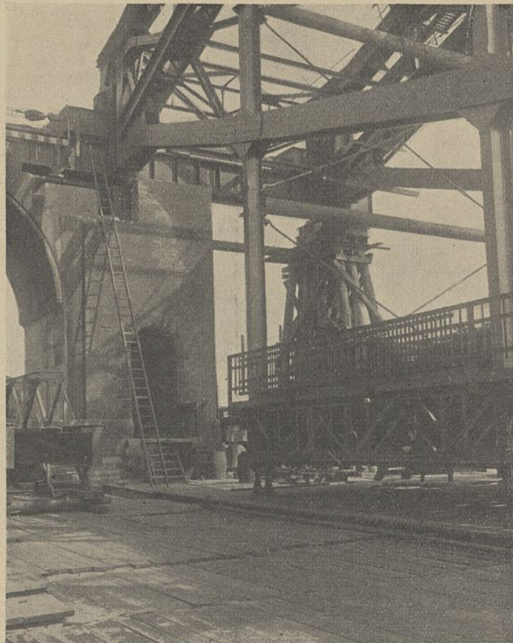
Abb. 9. Ueberbau IV vor der Einfahrt
