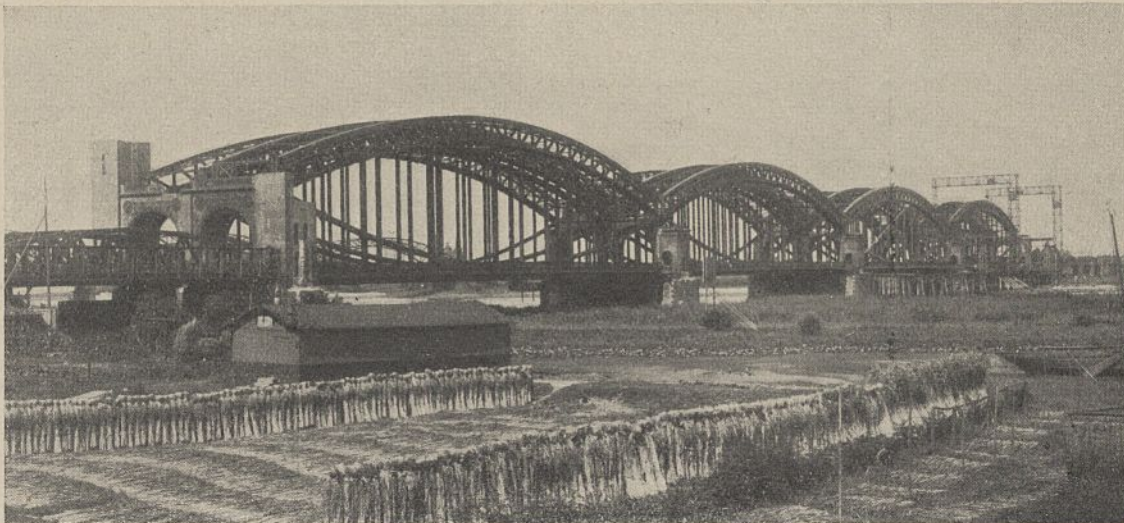
Abb. 10. Ansicht der fertiggestellten Brücke.
