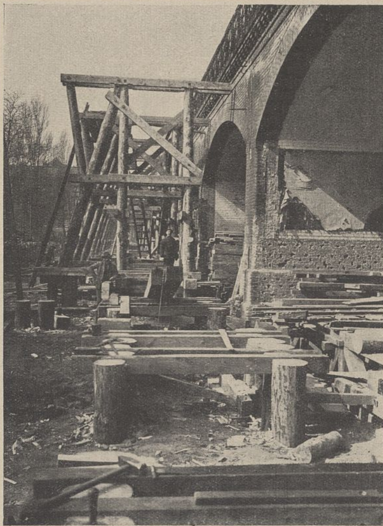
Abb. 22. Die Hilfsbrücke links der Spree.
