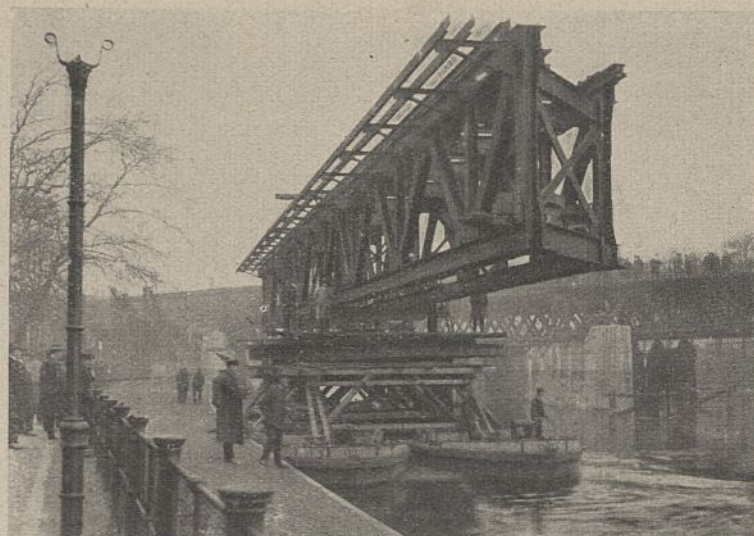
Abb. 24. Einfahren eines Fachwerküberbaues.
