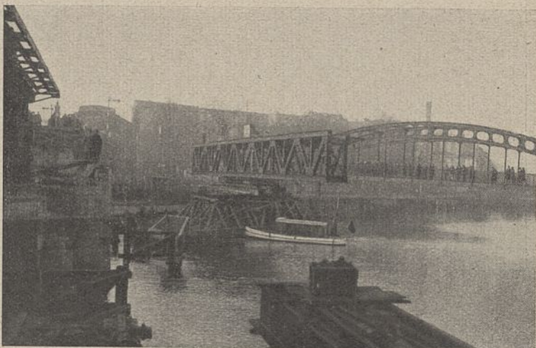
Abb. 26. Einfahren eines Fachwerküberbaues.
