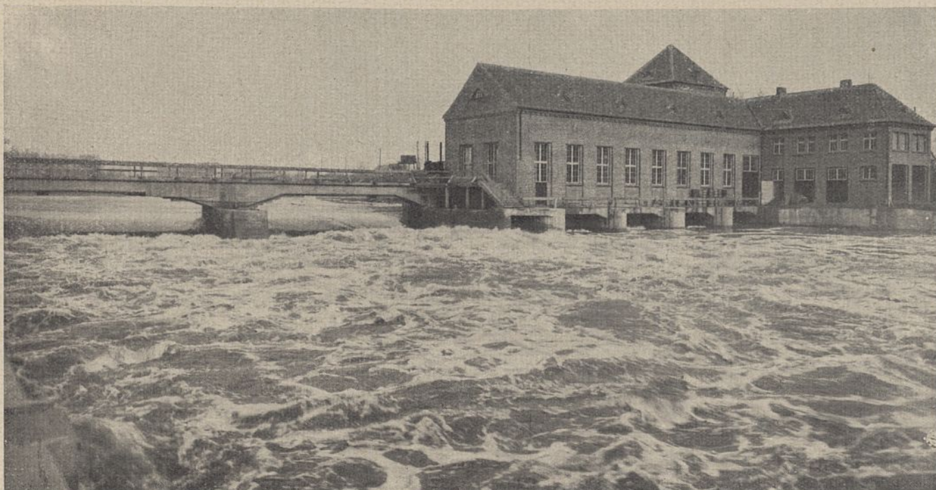
Abb. 10. Kraftwerk bei Groß-Wohnsdorf bei Hochwasser.
