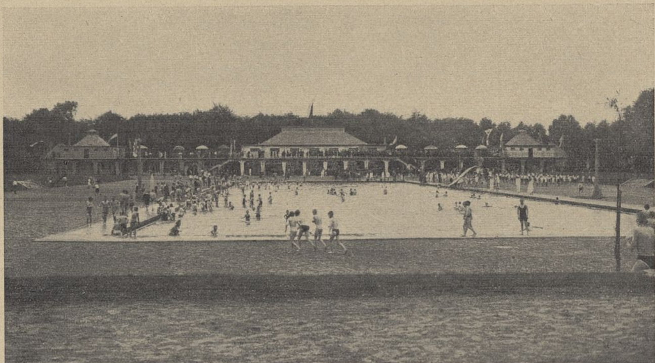
Abb. 4. Badebecken mit Betriebsgebäude.
