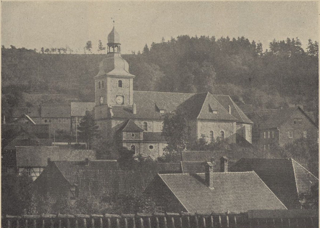
Abb. 33. Kirche in Geisleden, Gesamtansicht.
