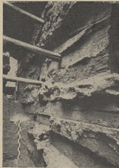
Abb. 5. Barbarathermen. Zwischen wilder Schalung gestampftes Fundamentmauerwerk.
