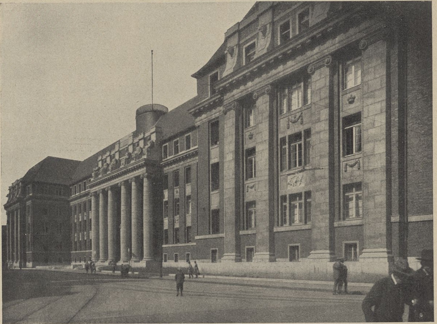
Abb. 1. Hauptansicht an der Mühlenstraße, Blickpunkt B (Tafel 1, Abb. 7).
