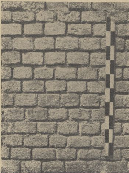
Abb. 1. Mauerwerk am Amphitheater in Trier, Kalksteinverblendung
