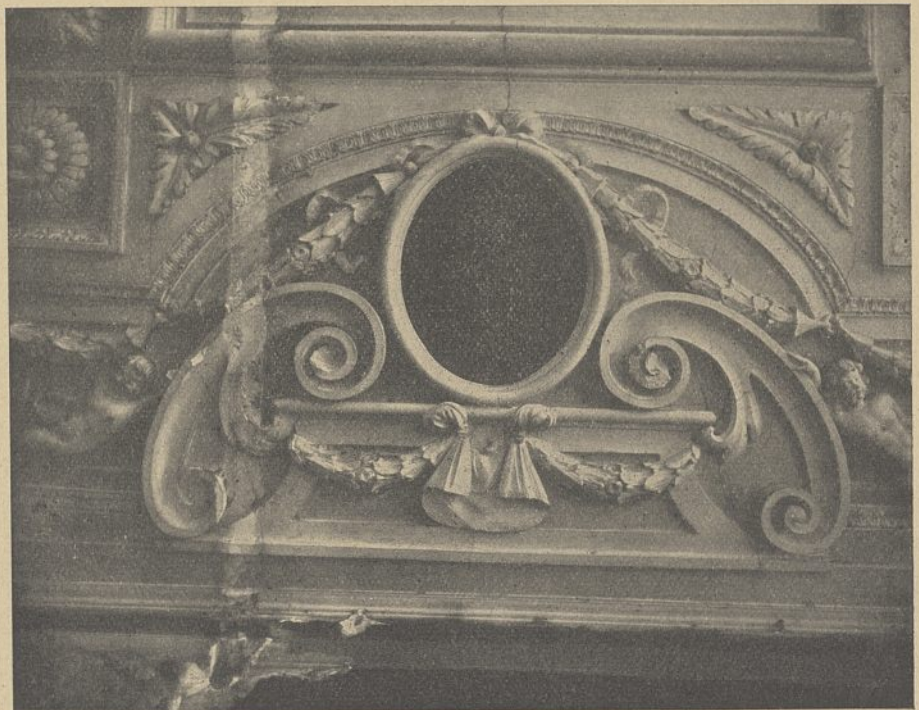
Abb. 22. Grundherr- und Hertelhaus, Decke.
