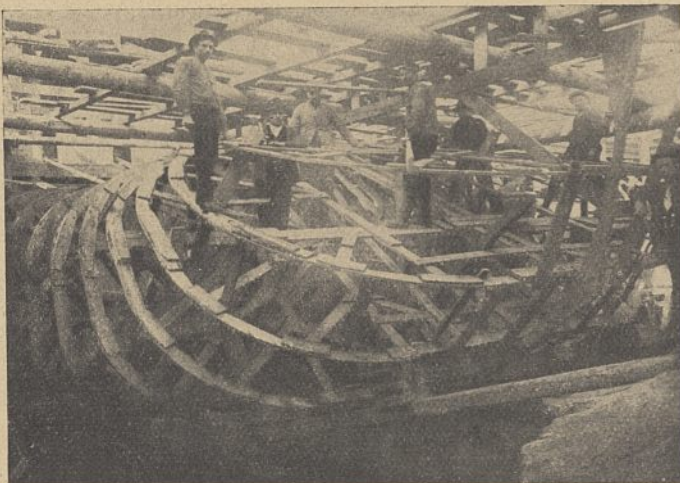
Abb. 20. Lehrbögen eines Turbinenauslaufes.
