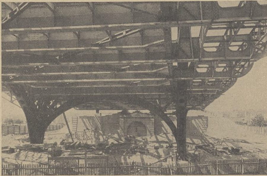
Abb. 109. Hindenburgbrücke, westliches Widerlager, von unten gesehen.
