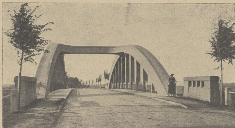
Abb. 21. Brücke Nr. 13 bei Stöcken.
