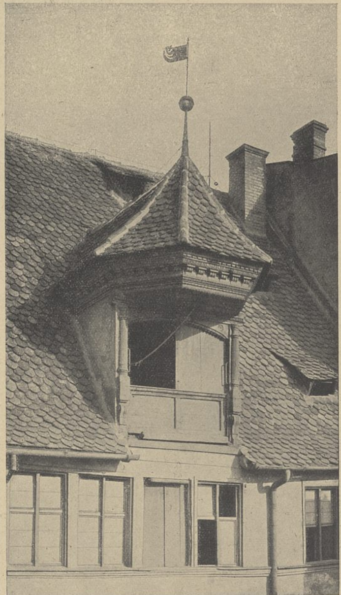
Abb. 18. Grundherr- und Hertelhaus, Dacherker.
