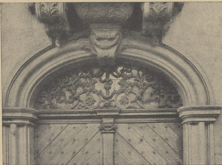
Abb. 15. Grundherr- und Hertelhaus, Oberlichtgitter.
