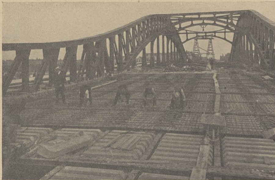
Abb. 110. Hindenburgbrücke, Ausführung der Fahrbahtafel.
