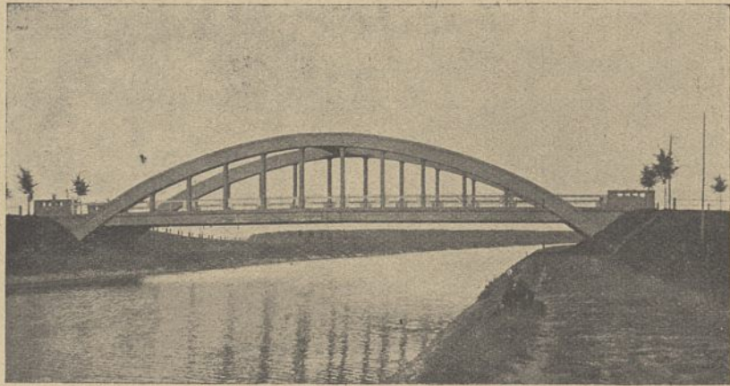
Abb. 20. Brücke Nr. 13 bei Stöcken.
