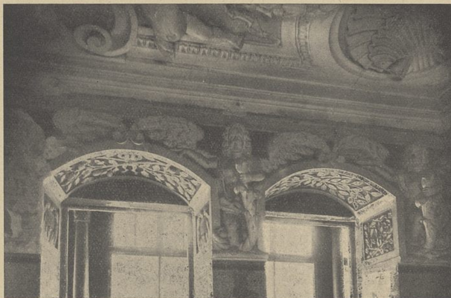
Abb. 20. Grundherr- und Hertelhaus, Fensterwand mit Decke.
