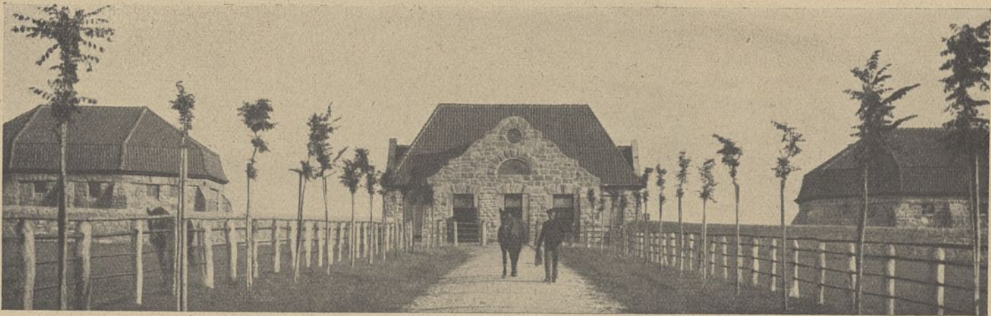
Abb. 49. Altefeld, Hengststall mit Deckhallen.
