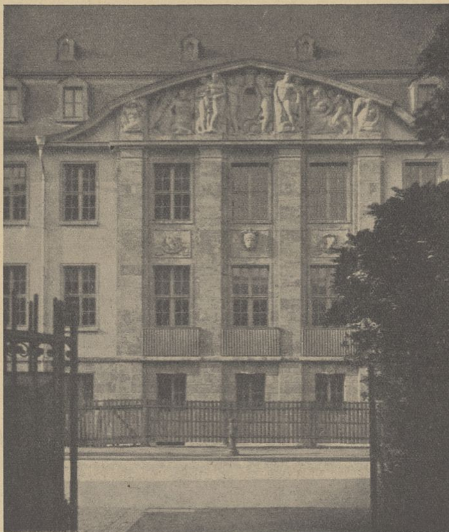
Abb. 2. Mittelteil der Straßenseite.
