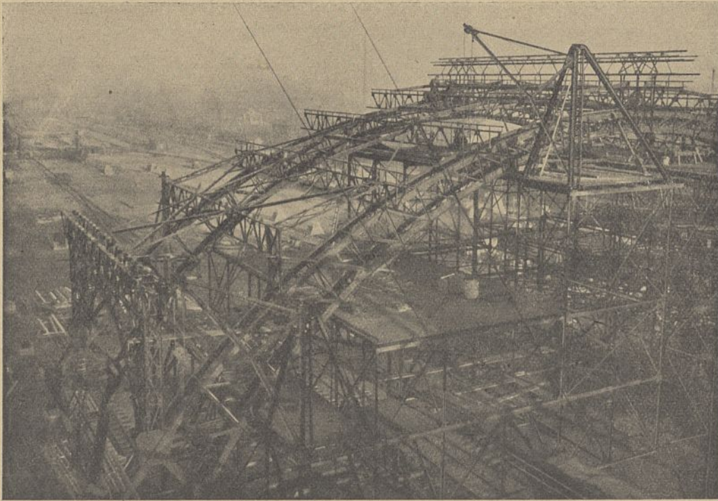
Abb. 216. Aufstellengerüst mit den beiden ersten Bindern.
