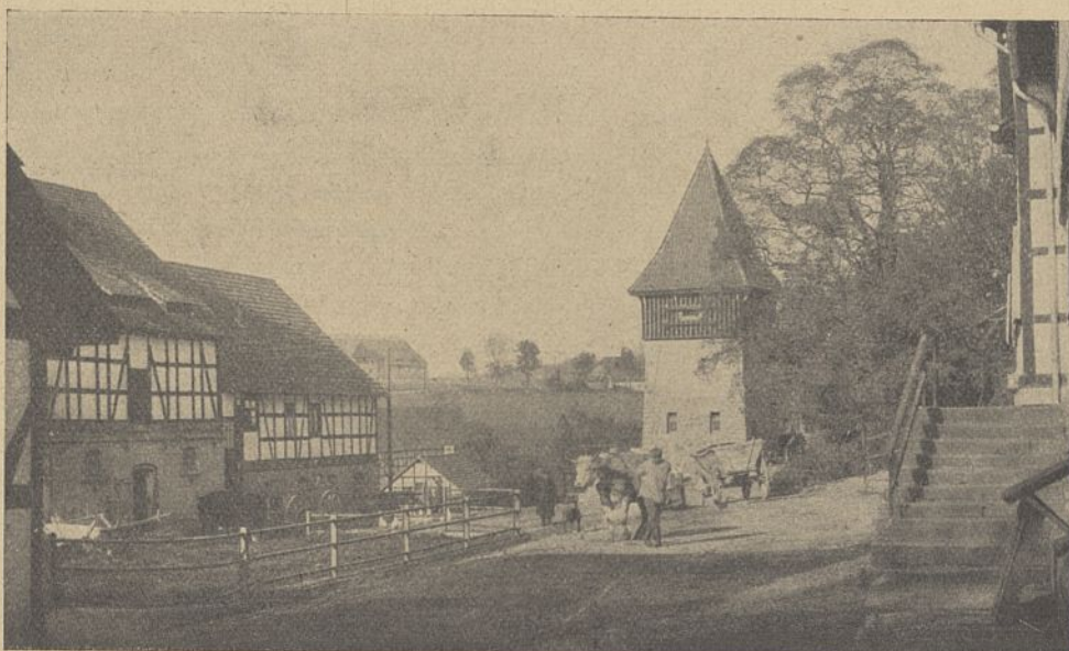
Abb. 58. Altefeld, Der alte Heidelberger Hof mit neuem Umformerhaus.
