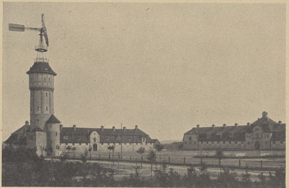
Abb. 22. Marienwerder, Wasserturm, Ansicht von Westen.
