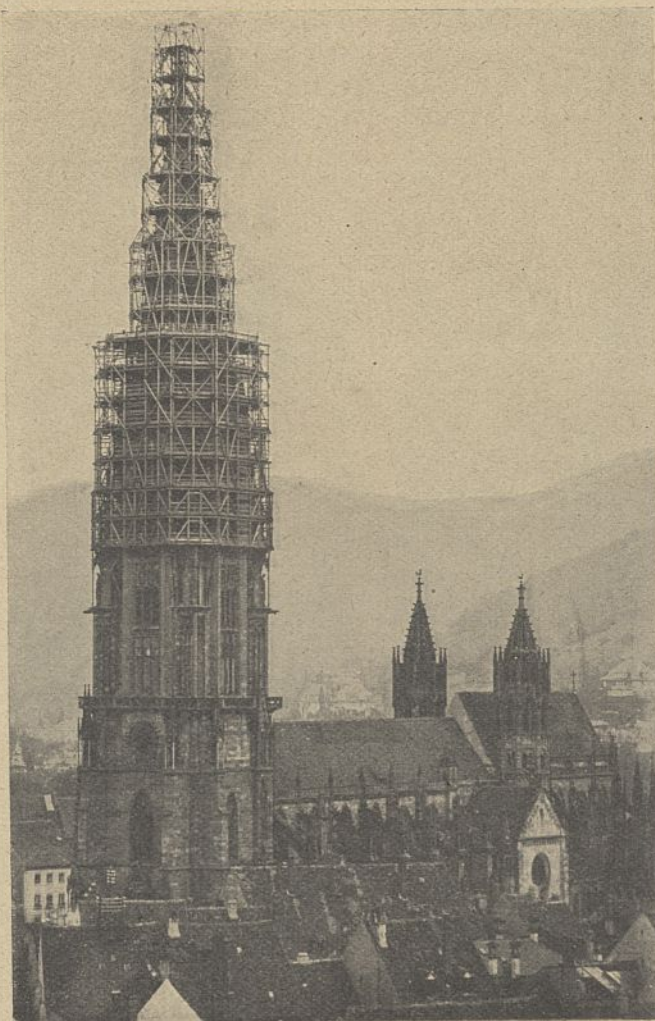
Abb. 10. Einrüstung der Achteckhalle und des Helmes.
