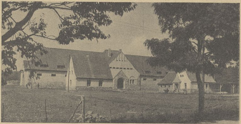
Abb. 53. Altfeld, Stutenstall mit Wärterhäusern.
