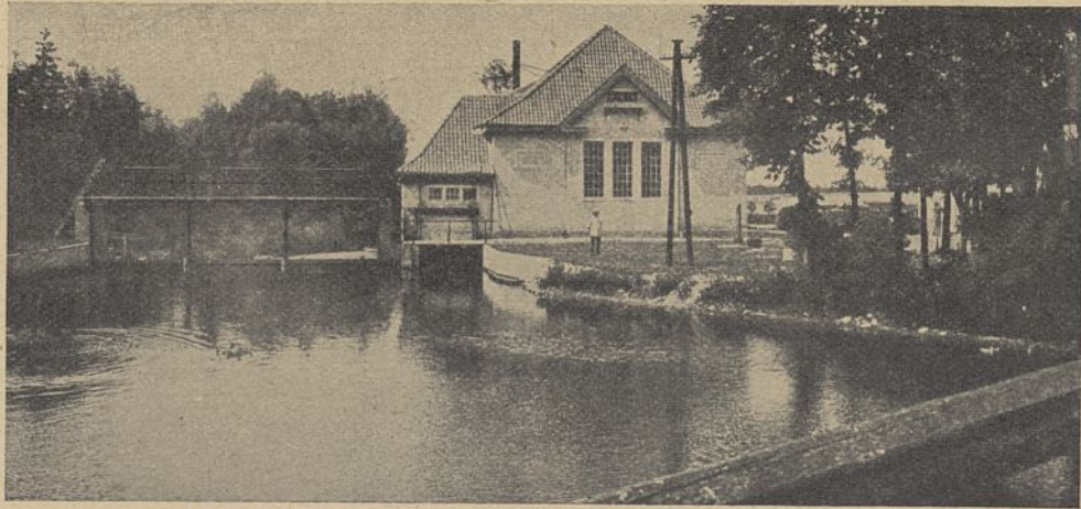
Abb. 3. Trakehnen, Elektrische Zentrale mit Wehr in Pakallnischken vom Oberwasser gesehen.
