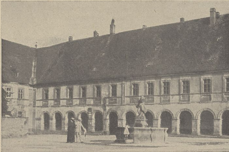
Abb. 13. Tüchelhausen, äußerer Hof, Marienbrunnen.
