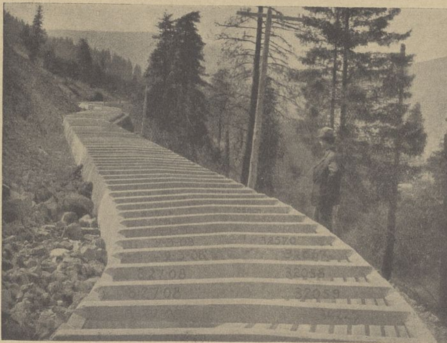
Abb. 17. Betonierter Lauf des Tieton-Kanals. Yakima-Projekt in Washington.
