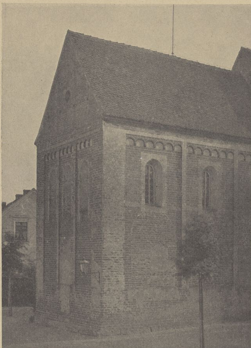
Abb. 1. Jerichow, Stadtkirche mit den Durchbruchspuren für das Seitenschiff.
