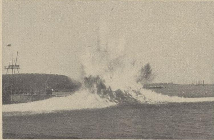
Abb. 9. Sprengung an der Kreuzermole.
