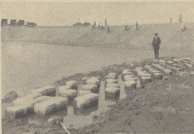
Abb. 2. Überreste des alten Eiswehres im Weichsel-Nogat-Kanal.
