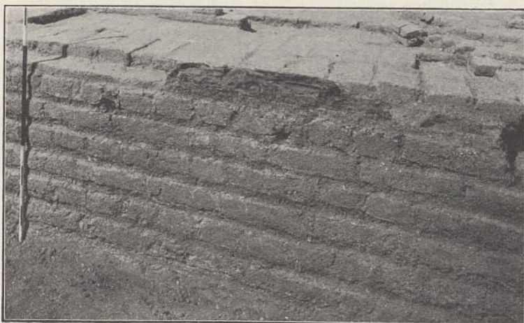
Abb. 3. Holzeinlagen in einer Mauer des Hauses J 53, 1.
