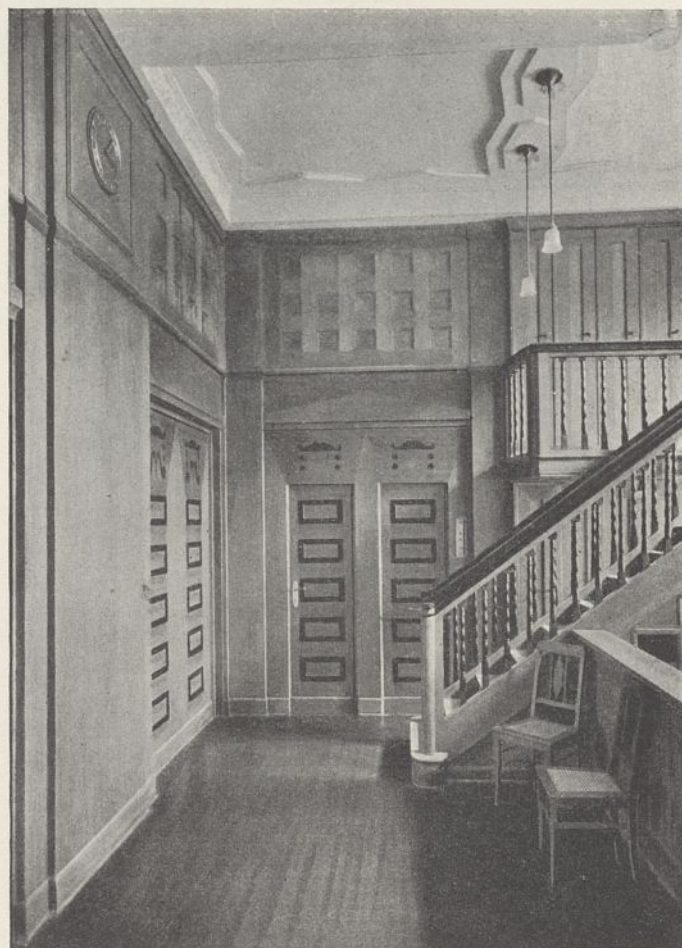
Abb. 16. Anmelderaum und Kleiderablage im Erdgeschoß.
