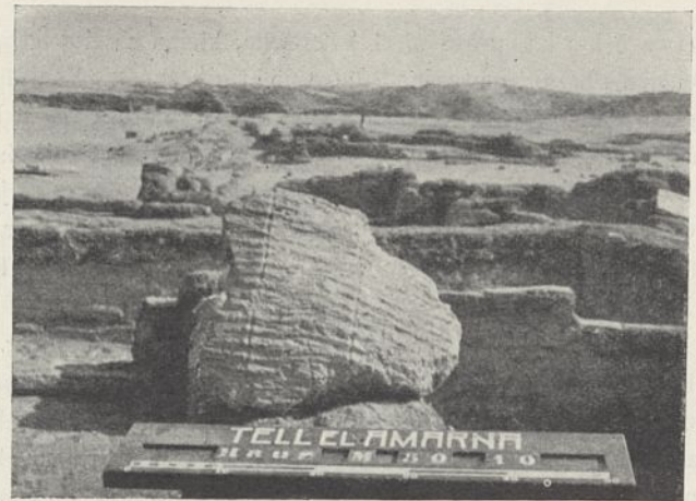
Abb. 5. Nilschlammestrich mit Abdruck der Matte darunter von einer Deckenkonstruktion im Hause M 50, 10.
