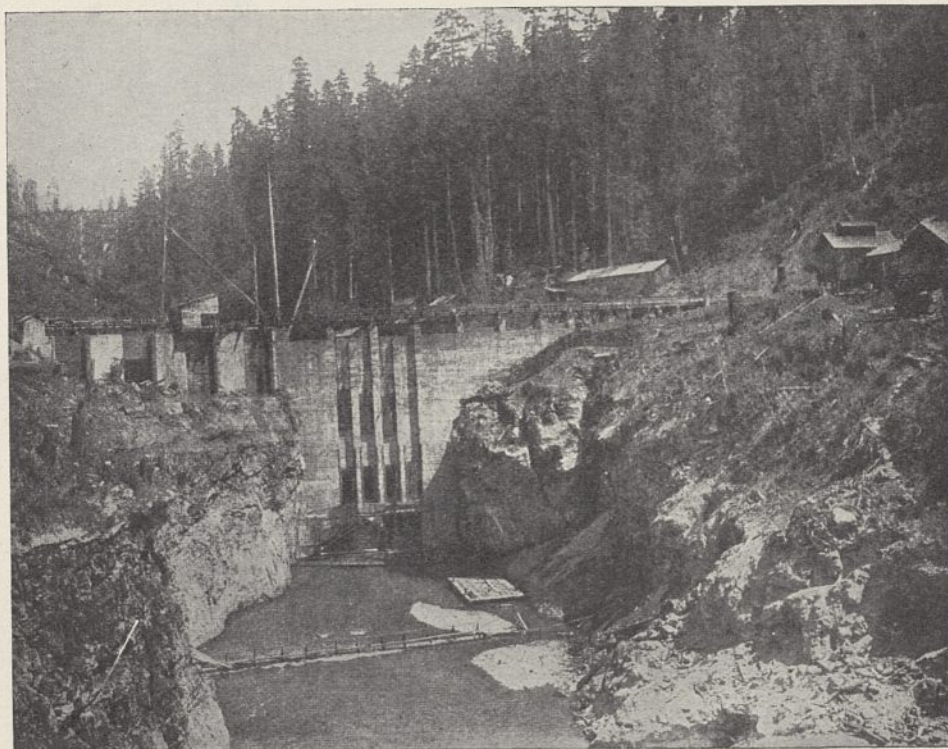
Abb. 13. Wasserseite mit der Spundwand im Vordergrund.
