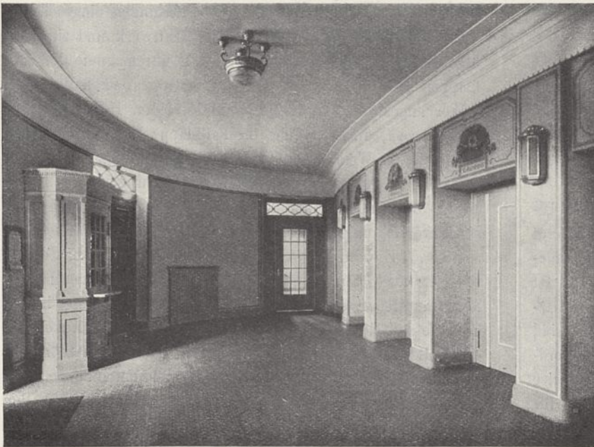
Abb. 5. Kassenhalle im Erdgeschoß.
