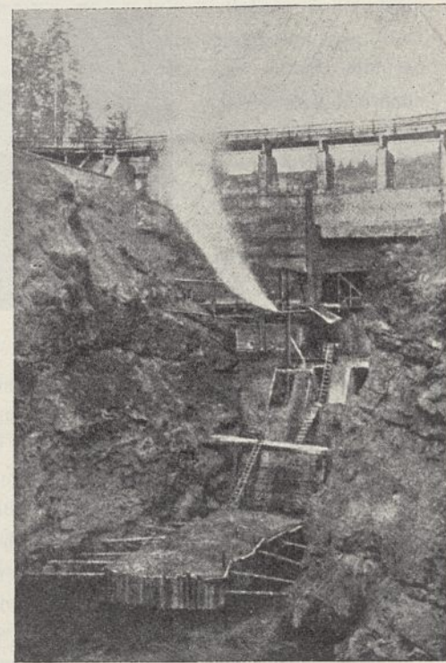
Abb. 14. Stahlpundwand-Senkkasten unterhalb des Dammes.
