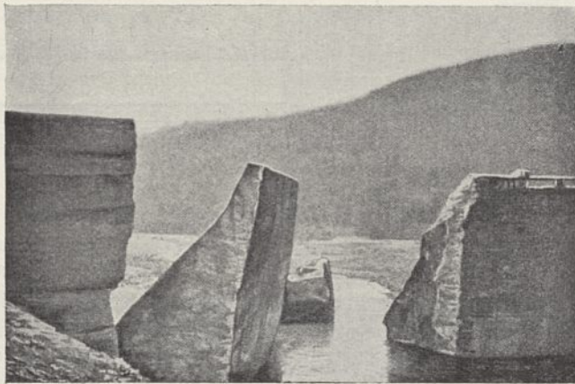
Abb. 28. Zerstörung der Austin-Sperrmauer. Blick talabwärts durch die östliche Durchbruchstelle.
