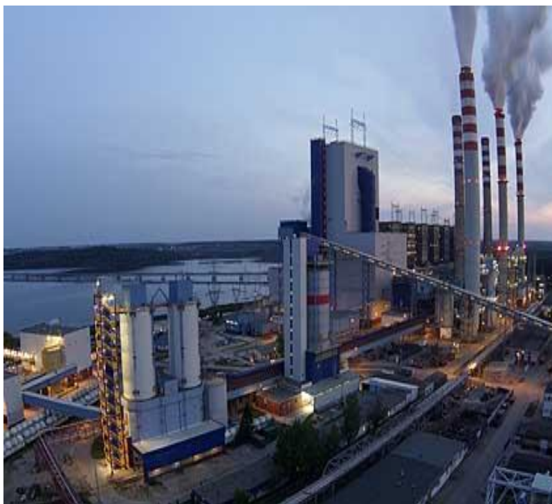
Rysunek 45 Elektrownia Pątnów (źródło: Źródło: http://zepak.com.pl/pl/elektrownie/elektrownia-patnow-ii.html )
