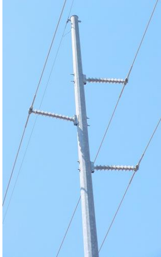
Rys. 2. Widok napowietrznej linii wysokiego napięcia z przelotowym układem izolatora zamocowanego do słupa w wykonaniu a) wsporczym, b) podwieszanym
