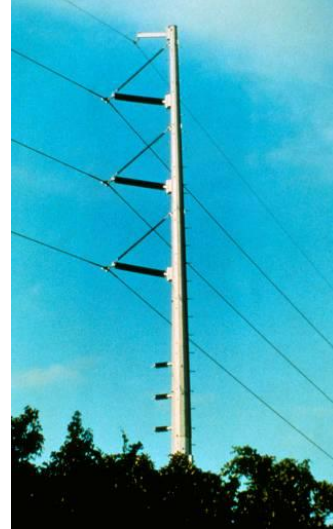
Rys. 2. Widok napowietrznej linii wysokiego napięcia z przelotowym układem izolatora zamocowanego do słupa w wykonaniu a) wsporczym, b) podwieszanym
