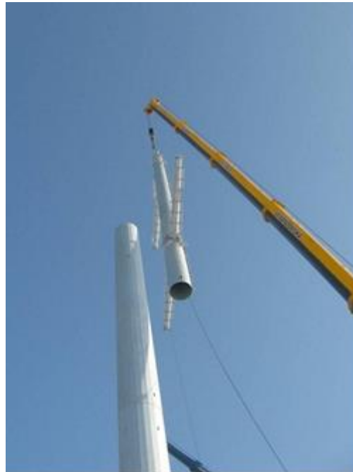
Rys. Z-A/12. Montaż górnych członów
