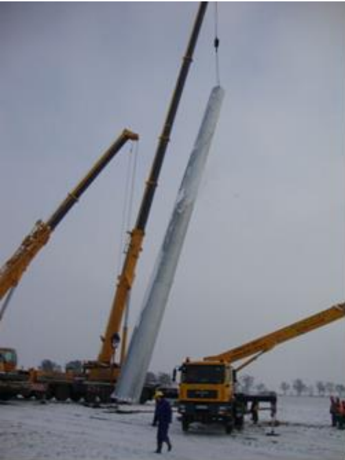
Rys. Z-A/11. Montaż dolnych członów
