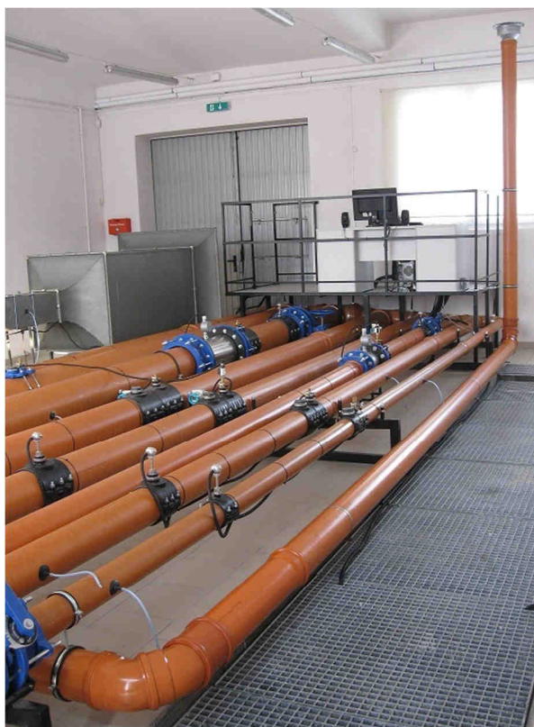
Rys. 13 Widok ogólny stanowiska pomiarowego po modyfikacji
