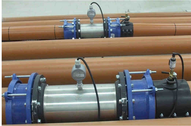
Rys. 22 Przepływomierze turbinowe firmy SPONSLEK SP6-CB-PH7-C-4X (DN150) i SP12-CB-PH7-C-4X (DN300) wraz ze wzmacniaczami impulsów
