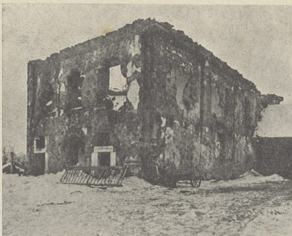
Fig. 14. Gorlice. Budowla t. zw. arjańska. Stan obecny.
