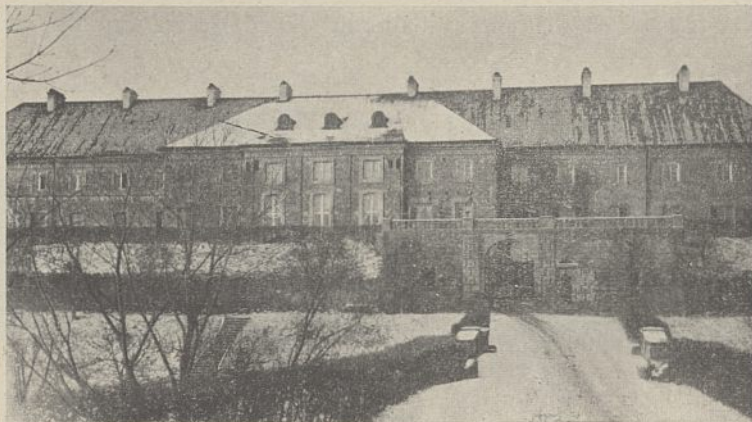
Fig. 11. Olyka. Fasada pałacu i brama przejazdowa od strony miasta (z fotogr.).
