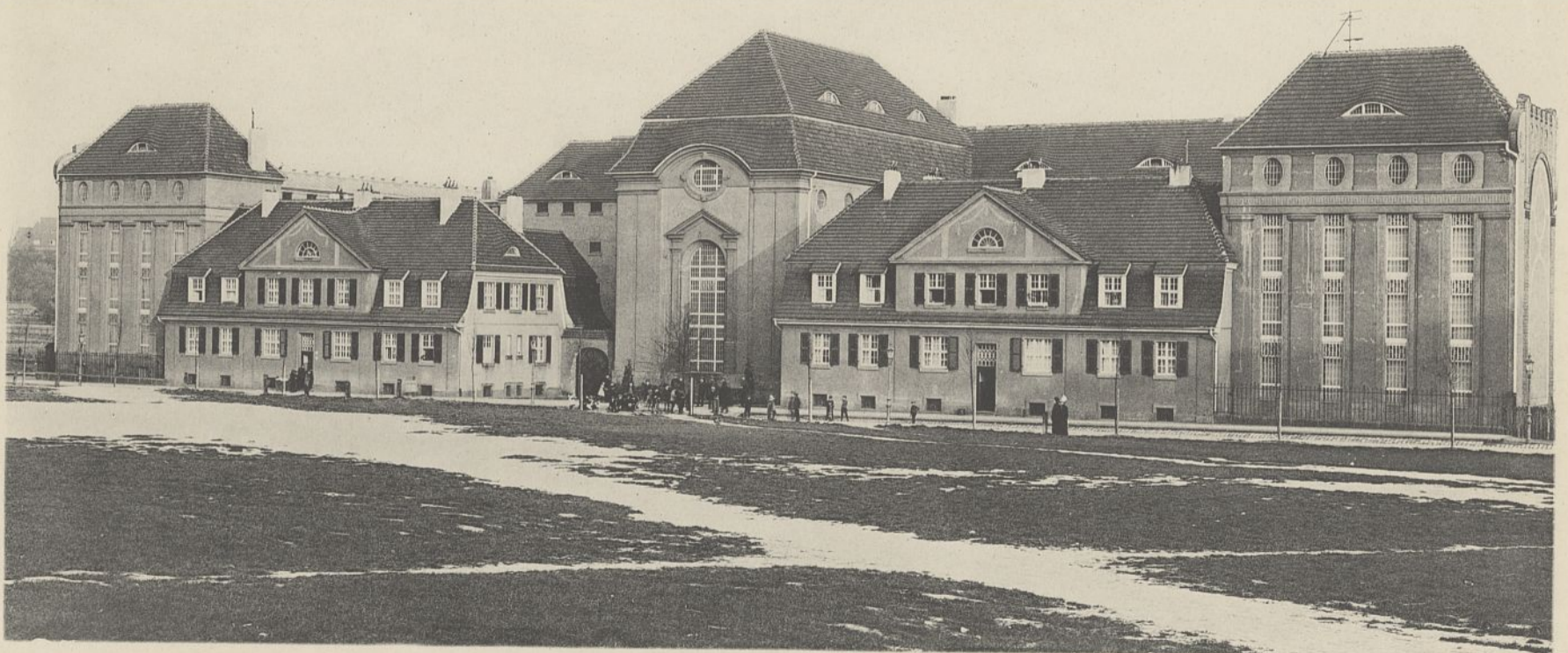
Abb. 2. Gefängnis und Beamtenwohnhäuser. Ansicht von der Andreasstraße.
