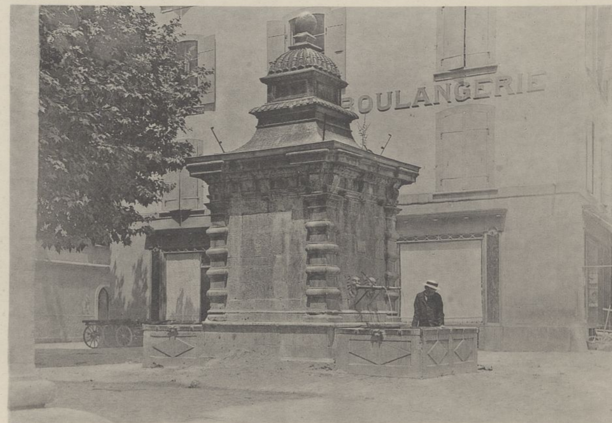
Abb. 4. Neuenburg, Straße „du Coq d'Inde“.
