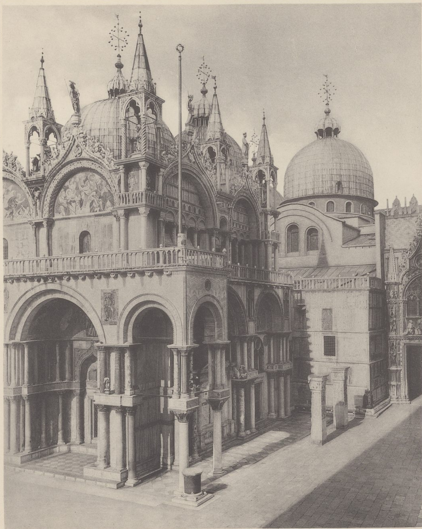
Abb. 1. Markuskirche in Venedig. Südwestliche Ecke.
