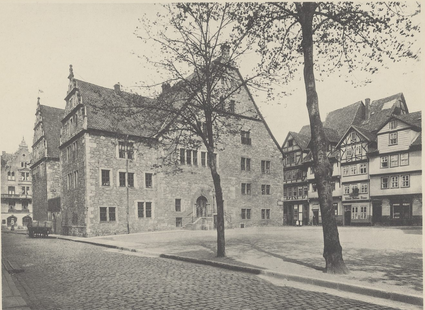
Abb. 2. Ansicht vom Kirchplatz.
