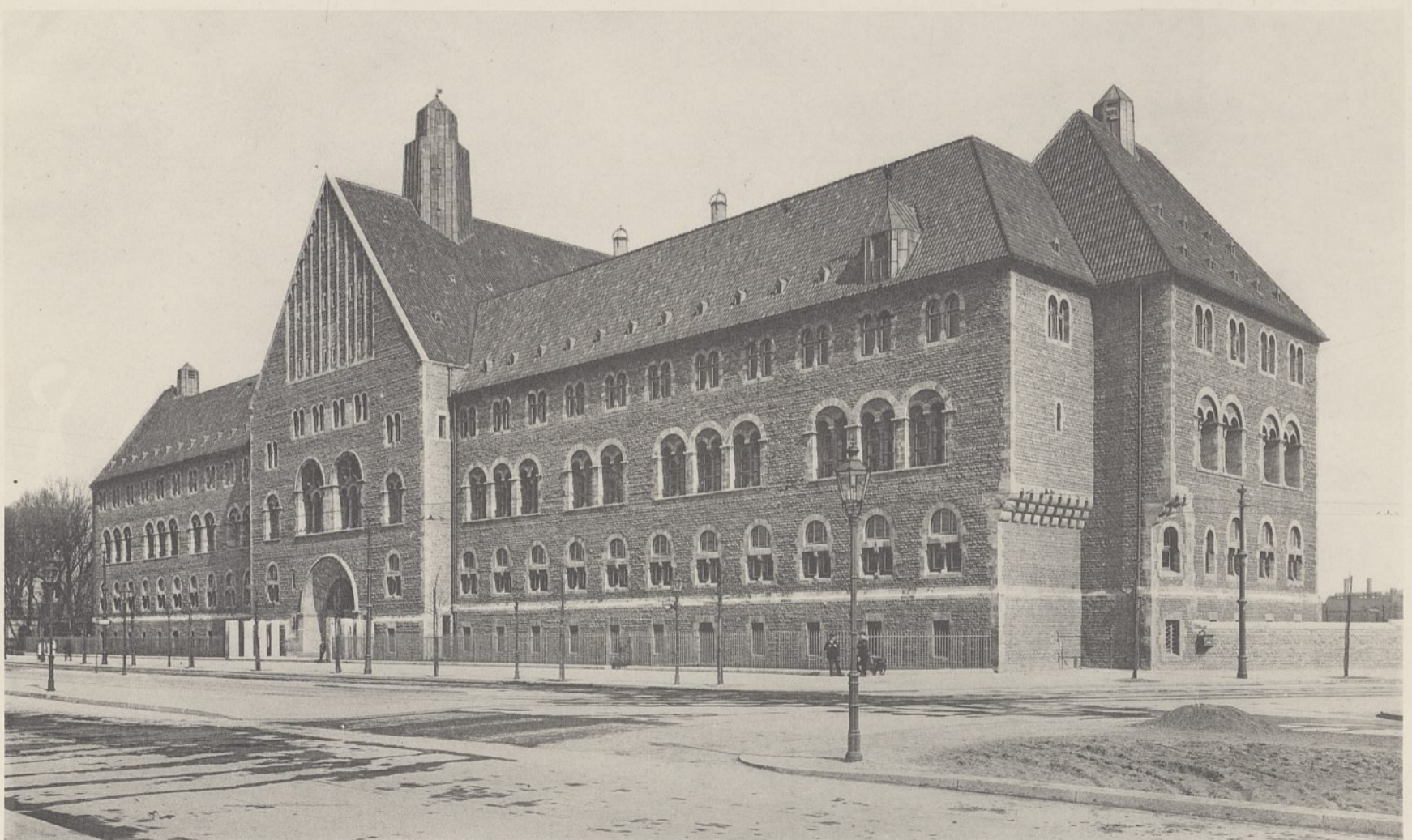
Abb. 2. Ansicht vom Tegeler Weg (Erster Bauteil).
