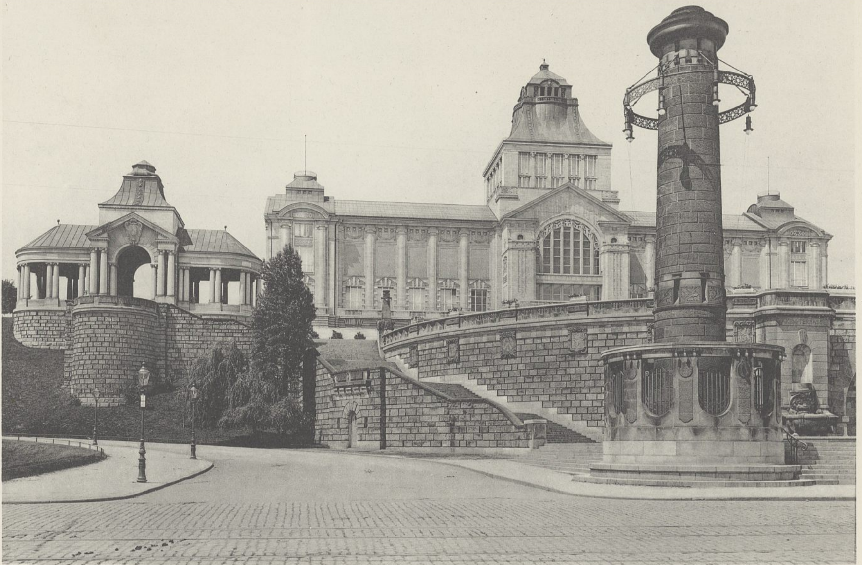
Abb. 1. Ansicht vom Bollwerk aus.
