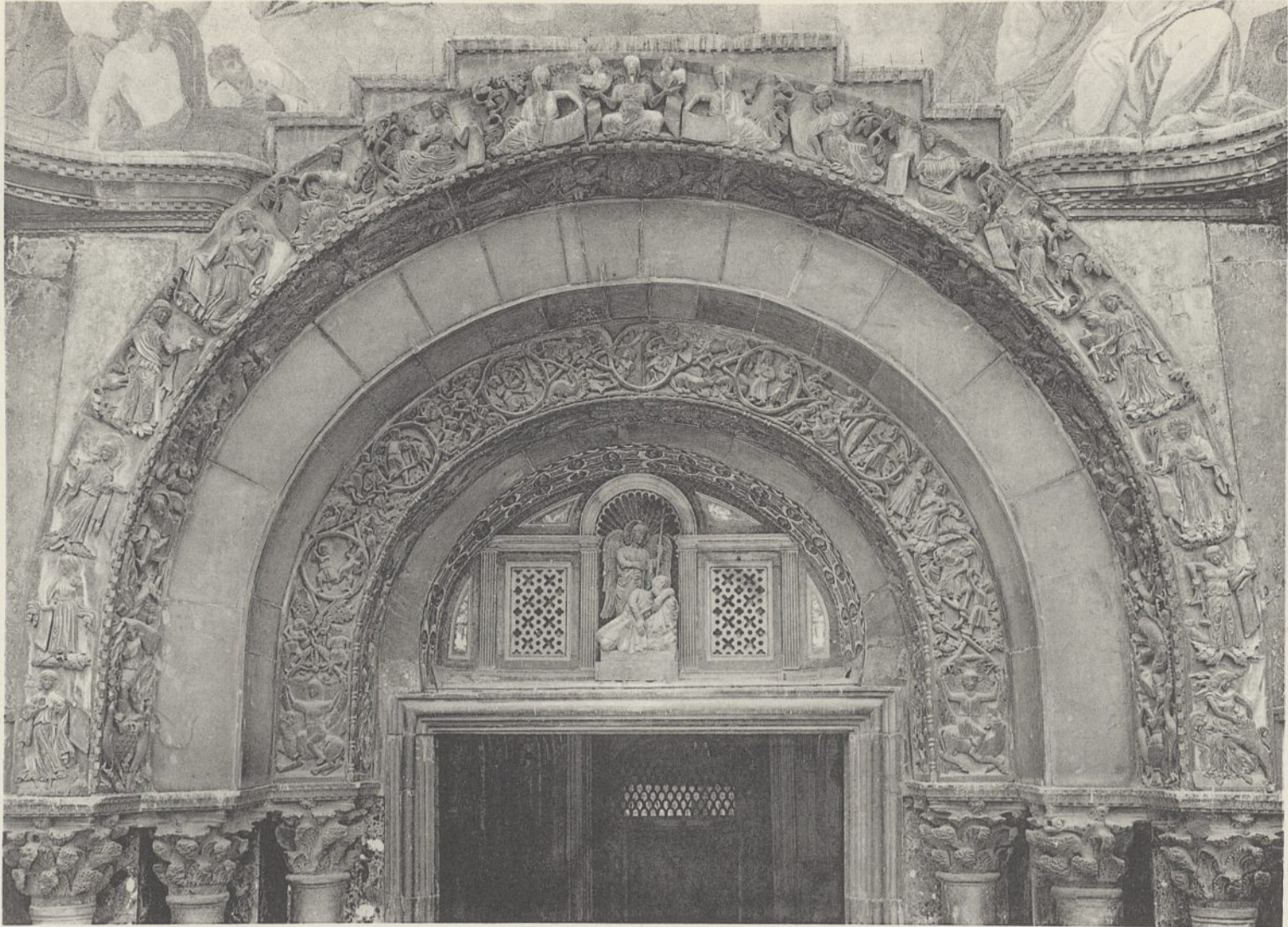
Abb. 1. Hauptportal von S. Marco in Venedig. Ansicht der beiden unteren Bogen.
