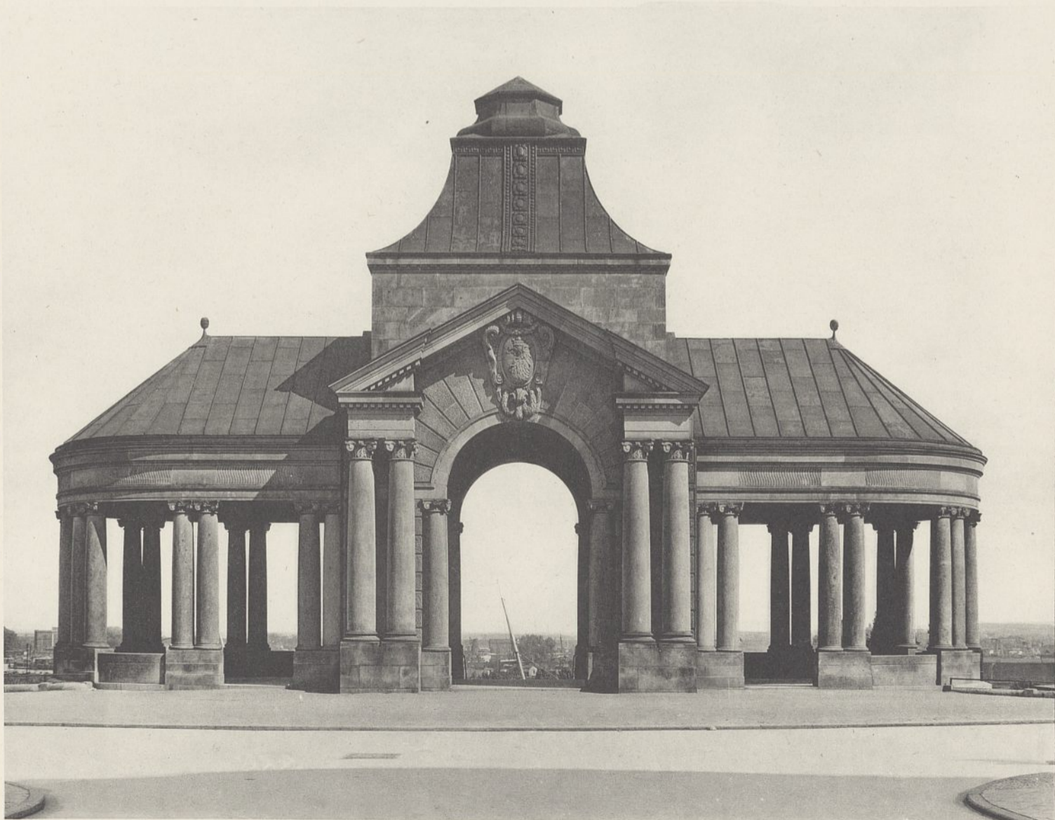
Abb. 2. Treppenhalle, Westansicht von der Stadtseite.
