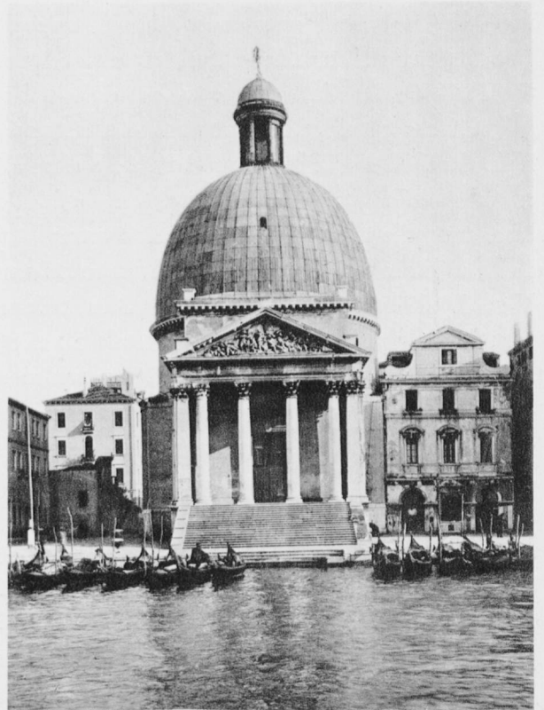
SAN SIMEONE PICCOLO: Fassade von GIOVANNI SCALFAROTTO (1718)
