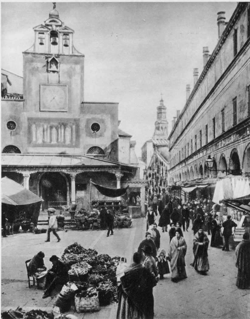
SAN GIACOMO DI RIALTO, auch SAN GIACOMETTO genannt, angeblich die älteste Kirche Venedigs (VI. Jhd.)
