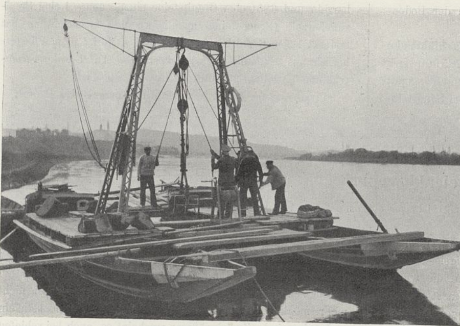
Abb. 1. Heben eines Steines mit der kleinen Zango.
