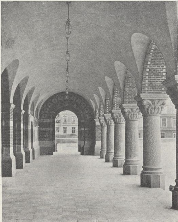
Abb. 6. Offene Vorhalle vor der Eingangshalle an der Vesterbrogade.
