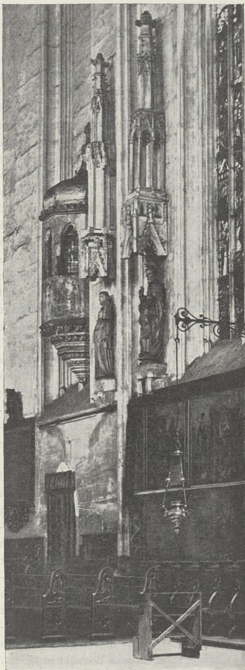
Abb. 6. Ansicht gegen den Chor der Kirche (vor der Wiederherstellung).
