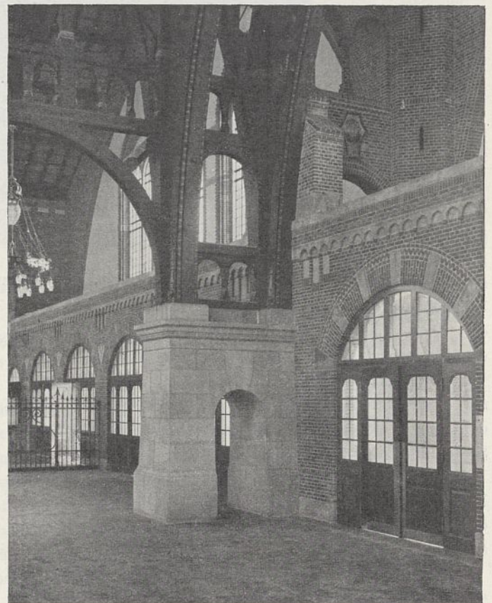
Abb. 4. Teil der östlichen Hallenwand an der Bernstorffsgade.
