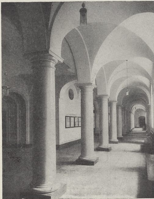
Abb. 3. Flur im Erdgeschoß zwischen Eingangshalle und Treppenhalle.
