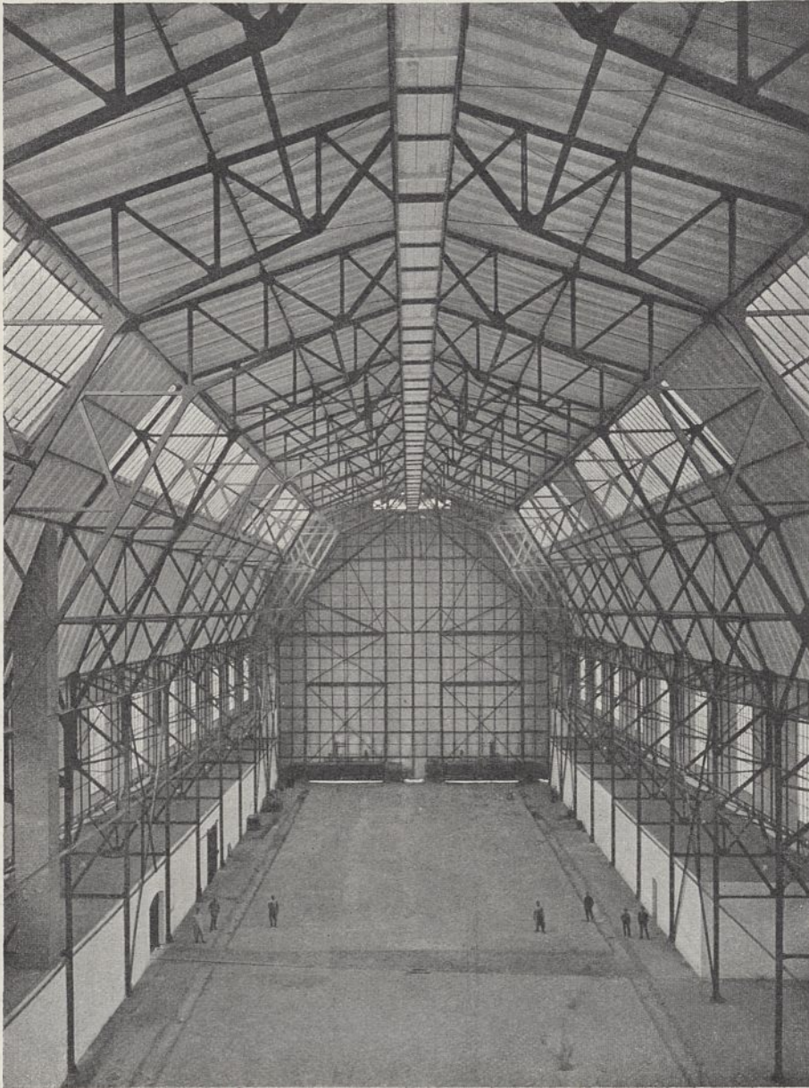
Abb. 99. Einschiffige Bergungshalle in Eisen. Ausführung: Unternehmer J. Gollnow u. Sohn in Stettin.
