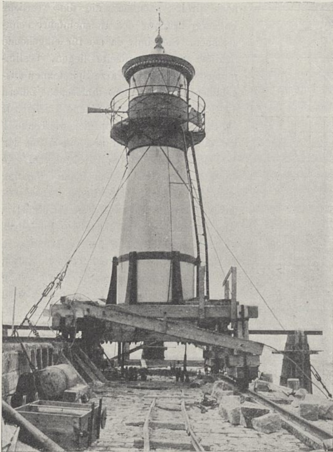
Abb. 11. Verschiebung des Leuchtturmes.
