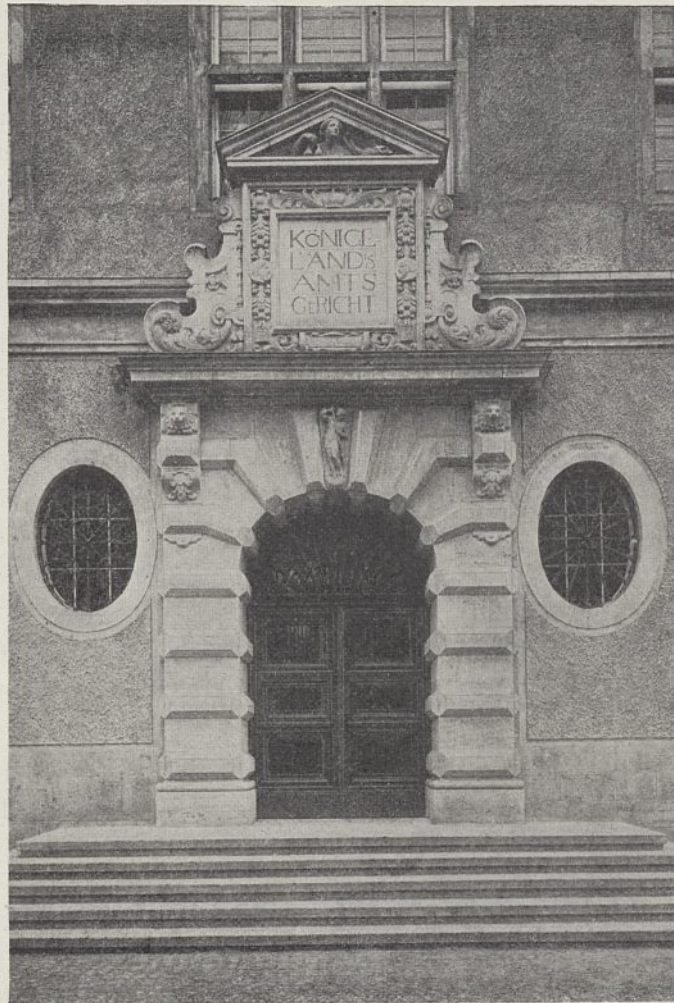
Abb. 2. Portal am Schützengang.
