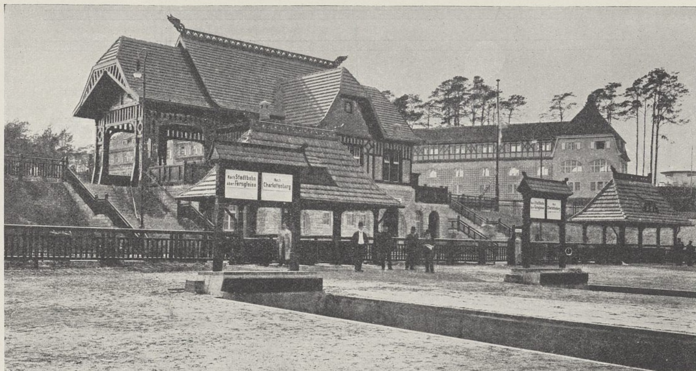
Abb. 4. Kopfbahnsteig des Bahnhofs Rennbahn mit den Sperren und der Empfangshalle. (Vgl. Zentralblatt der Bauverwaltung 1910, S. 557.)
