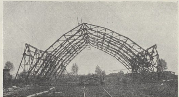
Abb. 115. Versetzbare einschiffige Halle in Eisen. Ausführung durch die Pat.-Inh. Ballonhallenbau- (Arthur Müller)-G. m. b. H. in Charlottenburg.
