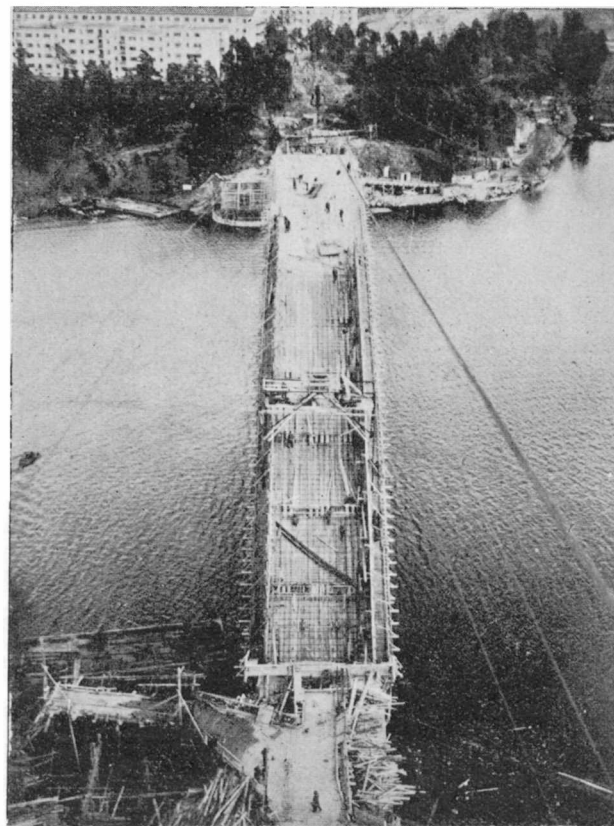
Ryc. 10. Widok ogólny w okresie układania wkładek łuku.
