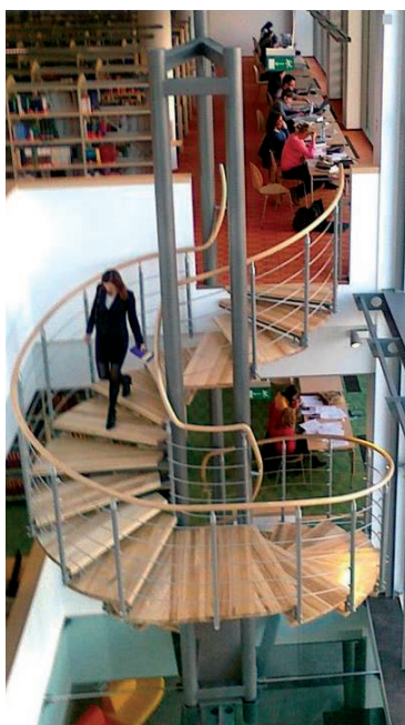
Fot. 4. Zawieszane schody w świetliku
