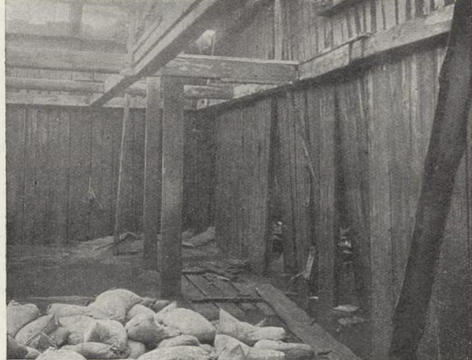
Abb. 7. Südliche Trennungsspundwand im Unterhaupt.
