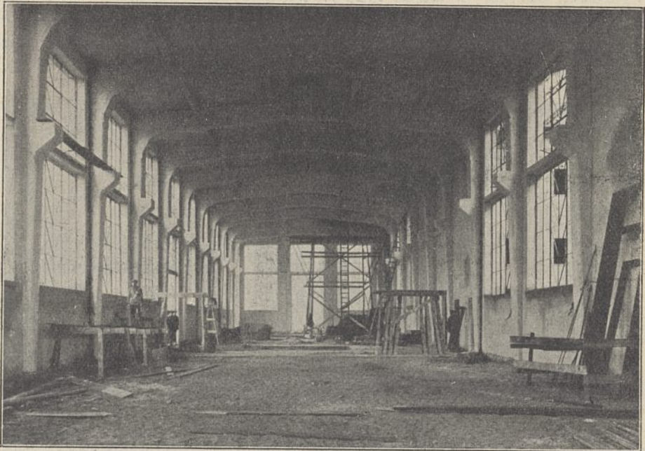
Rys. 4. Widok wewnętrzny hali dla prac technologicznych.
