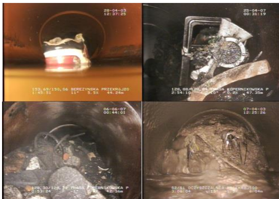
Rys. 6. Zatory w kanałach
