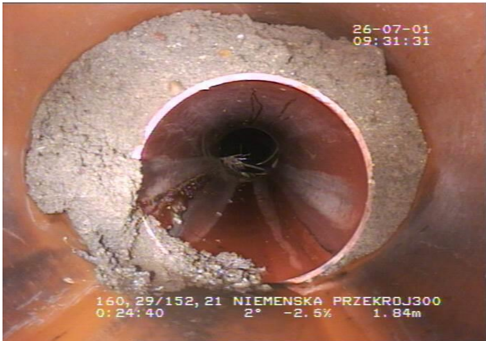
Rys. 12. Zmniejszenie średnicy kanału
