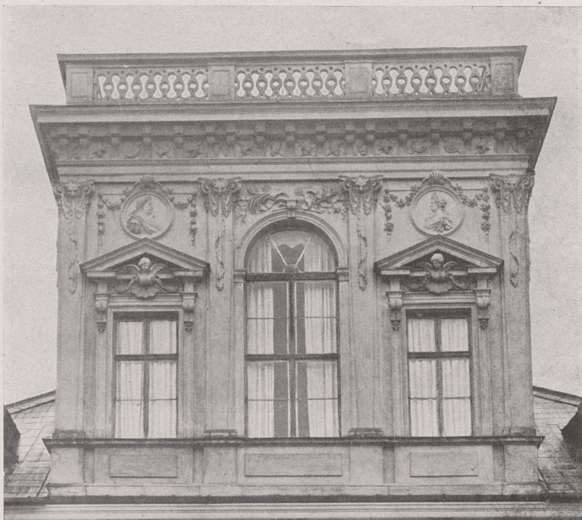
13. Wilanów, fasada drugiego piętra od ogrodu.
