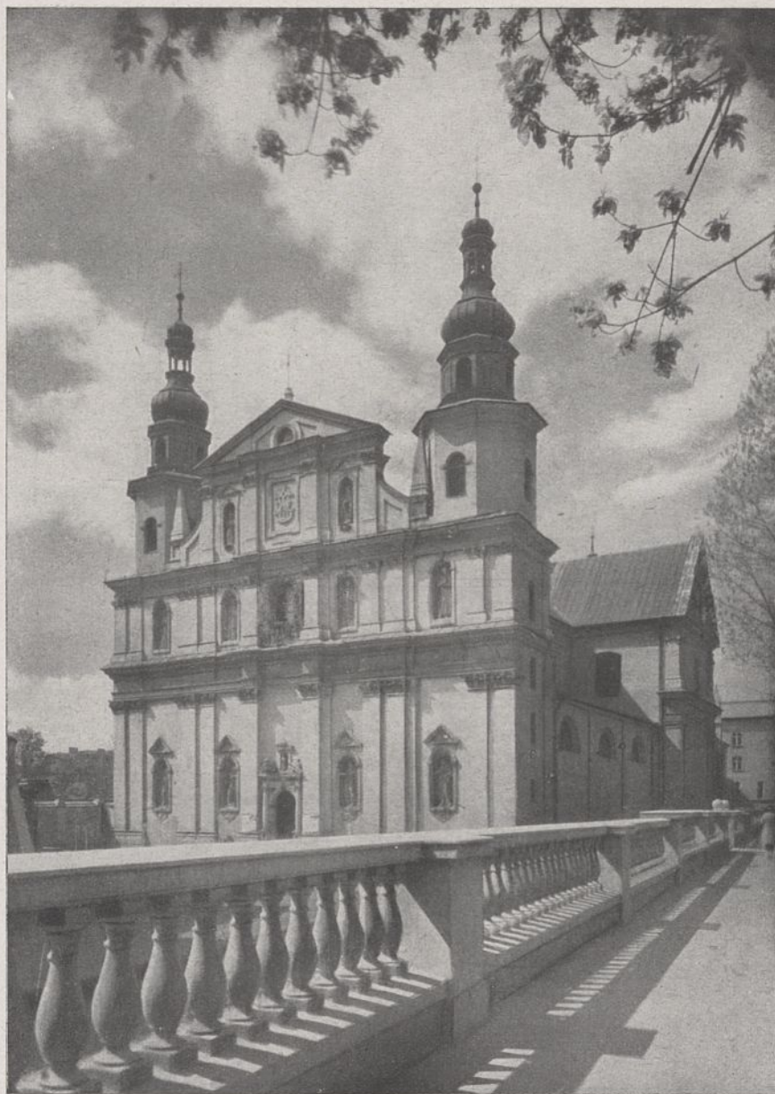
7. Kraków, kościół bernardynów, fasada.
