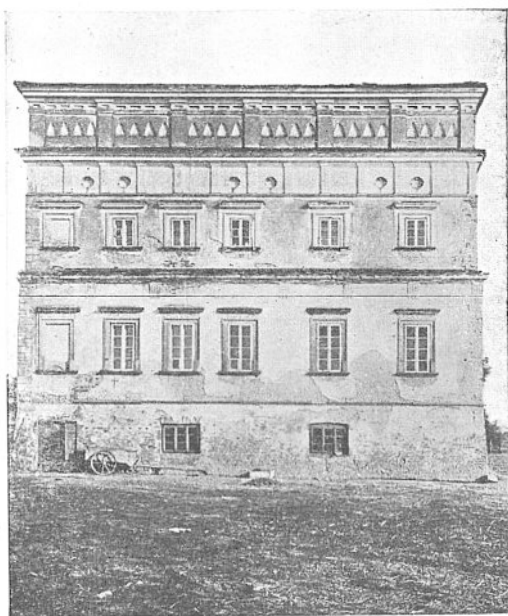
Fig. 35. Czemierniki, dwór. Widok od północy.
